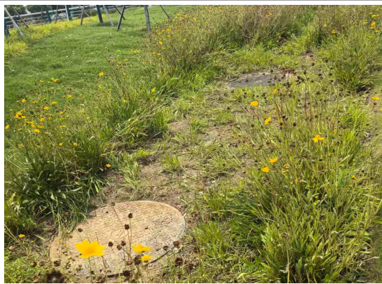
电缆施工区 撒播草籽（2026.6）
