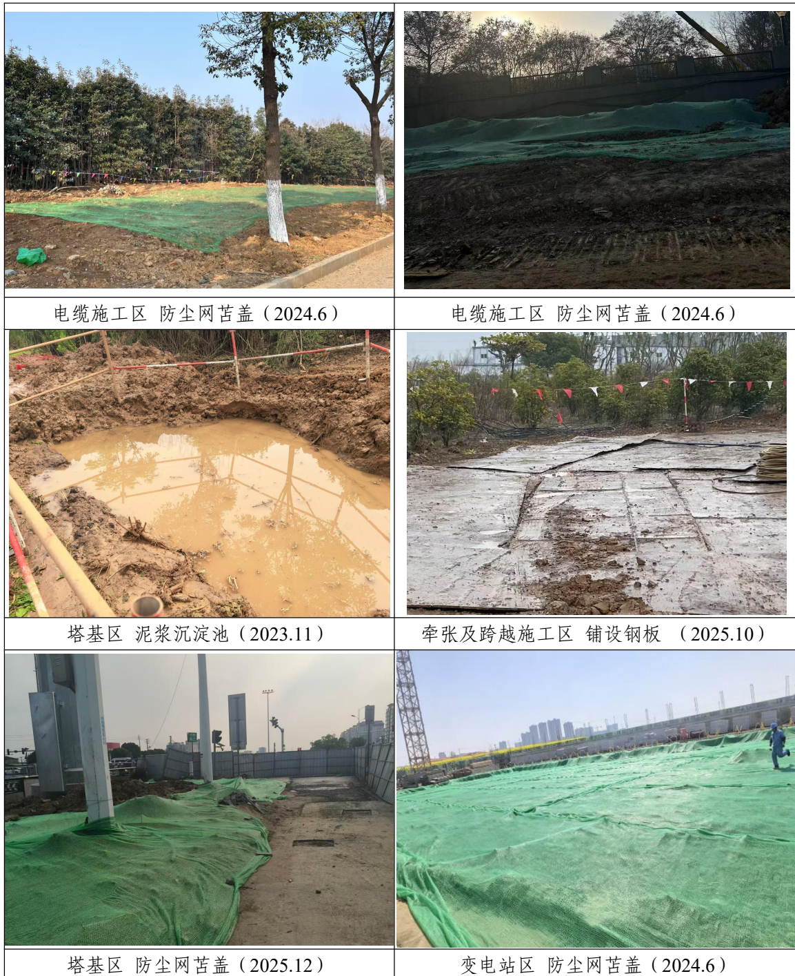
图 4-3 水土保持临时措施实施情况
