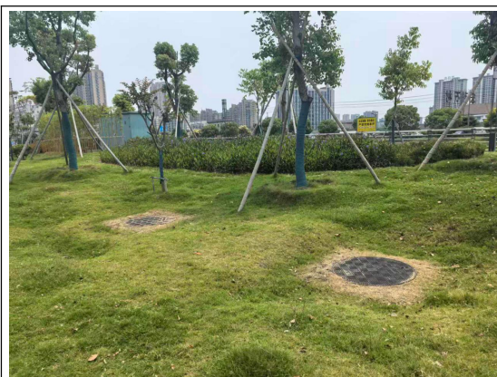
电缆施工区 撒播草籽（2026.6）
