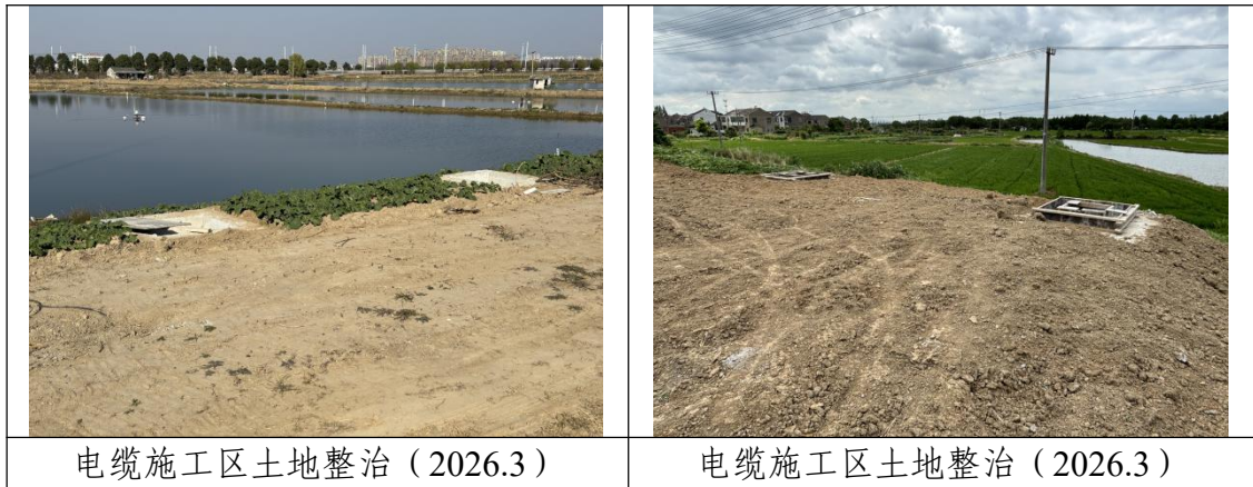
图 4-1 水土保持工程措施实施情况
