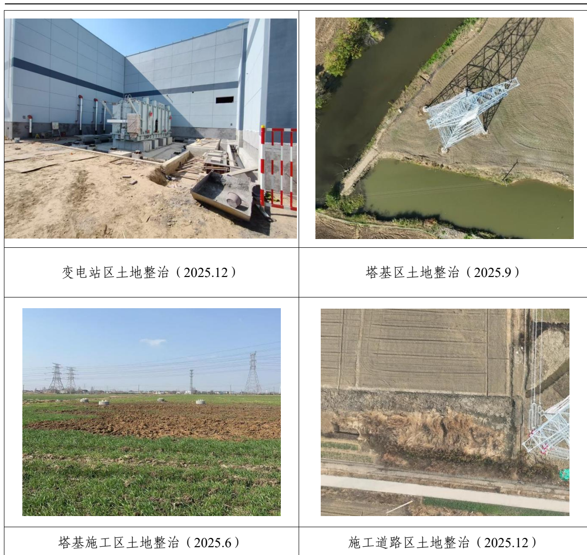
图 4-1 水土保持工程措施实施情况
