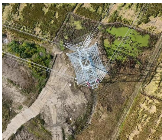
塔基区土地整治（2025.9）
