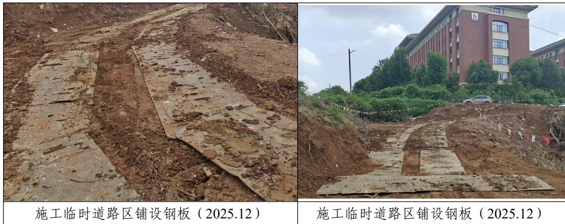
图 4-3 水土保持临时措施实施情况
