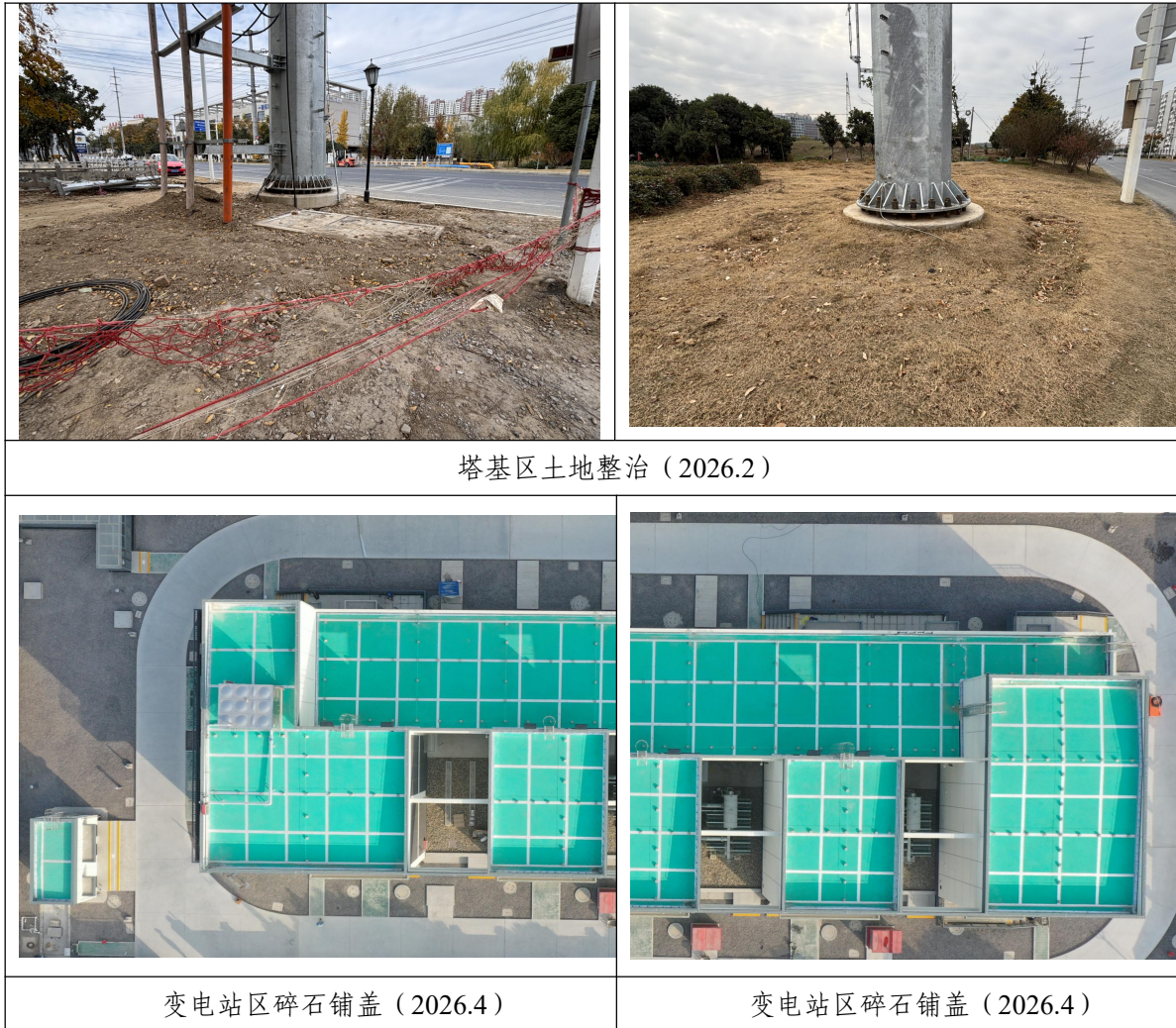
图 4-1 水土保持工程措施实施情况
