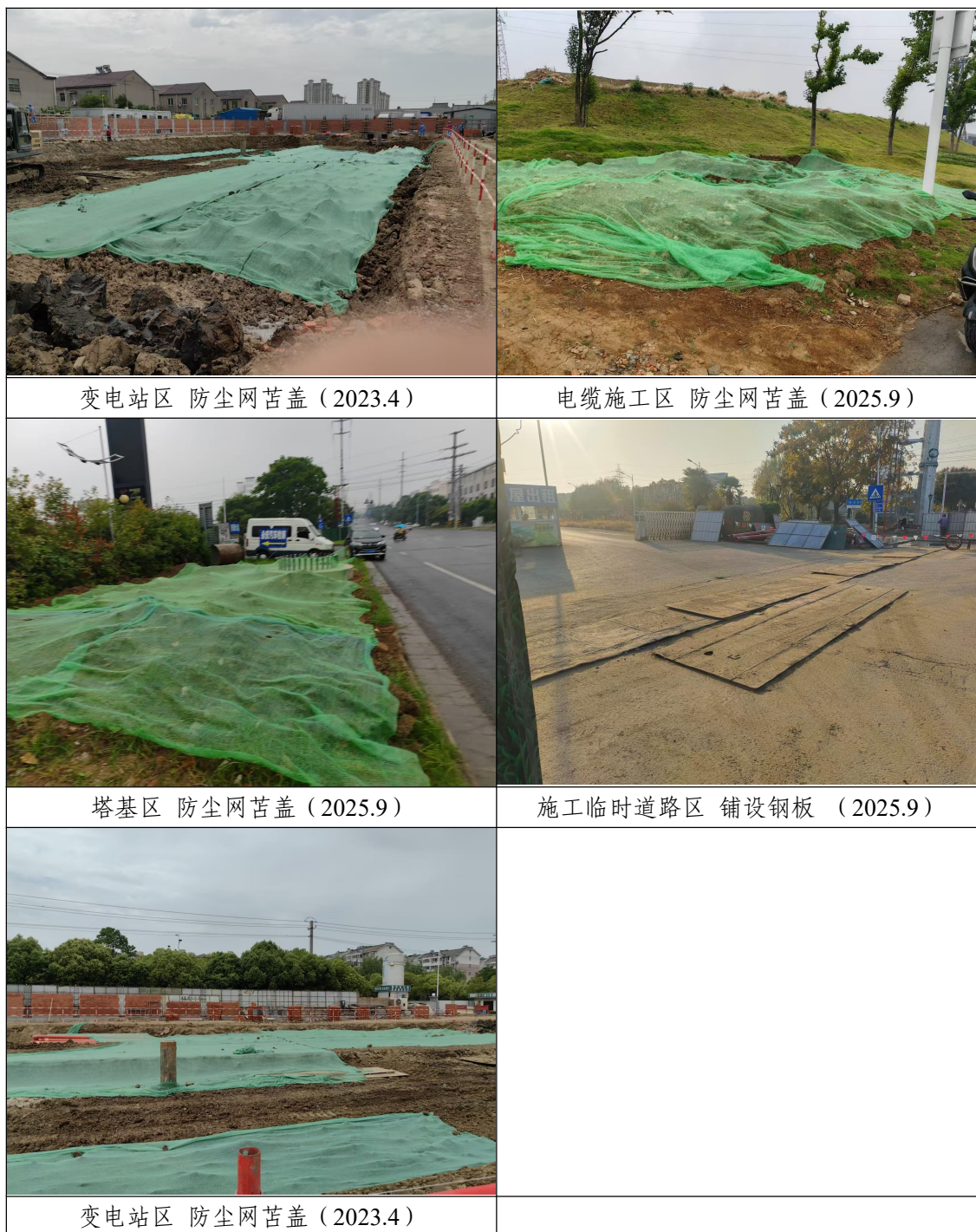
图 4-3 水土保持临时措施实施情况
