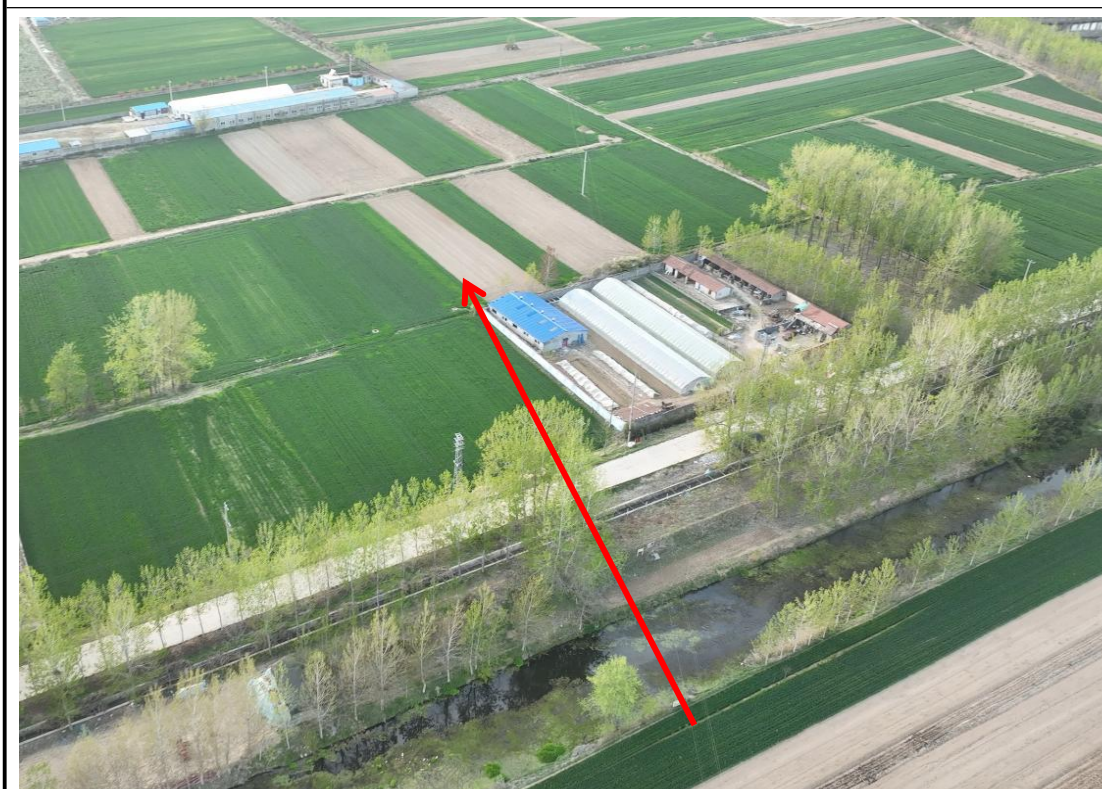
架空线路跨越围山河
