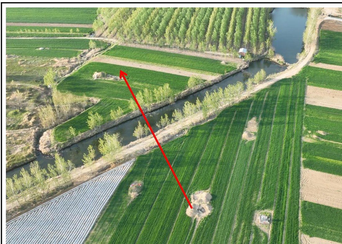
架空线路跨越龙梁河
