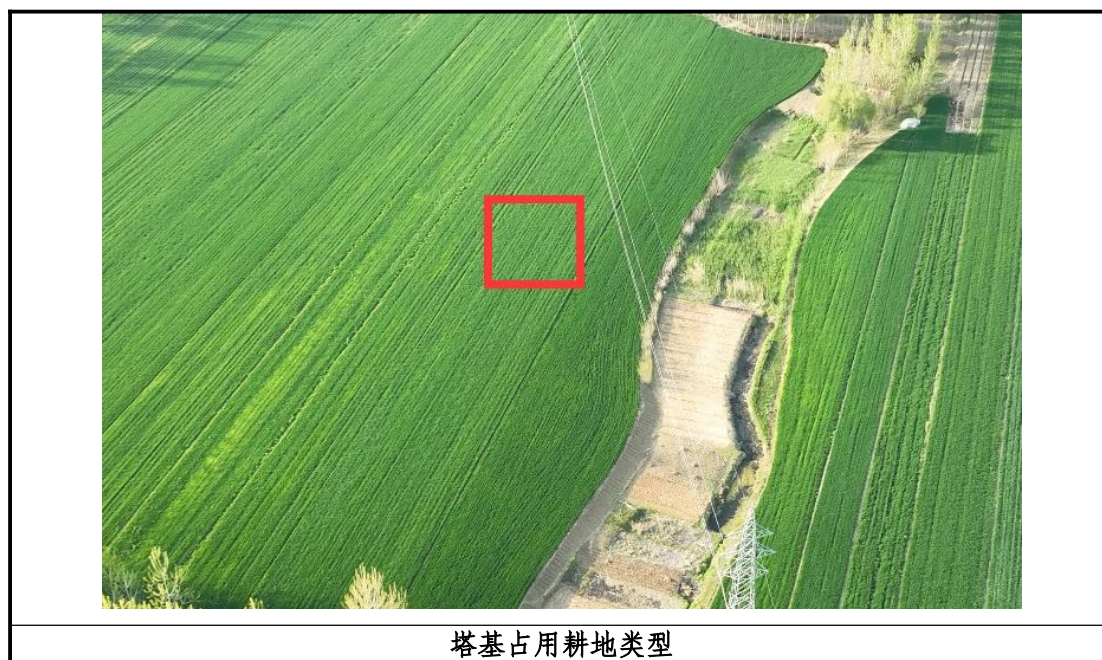
图 1.1-3 工程原地貌图 (拍摄时间: 2026 年 4 月)
