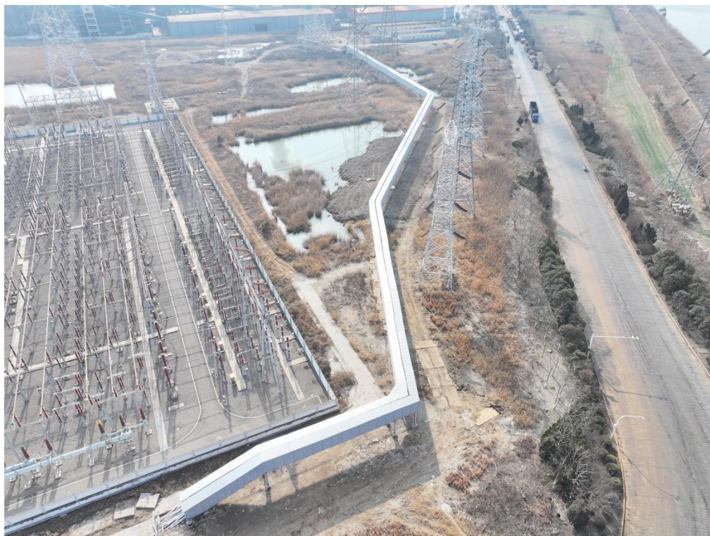
本项目电缆线路
