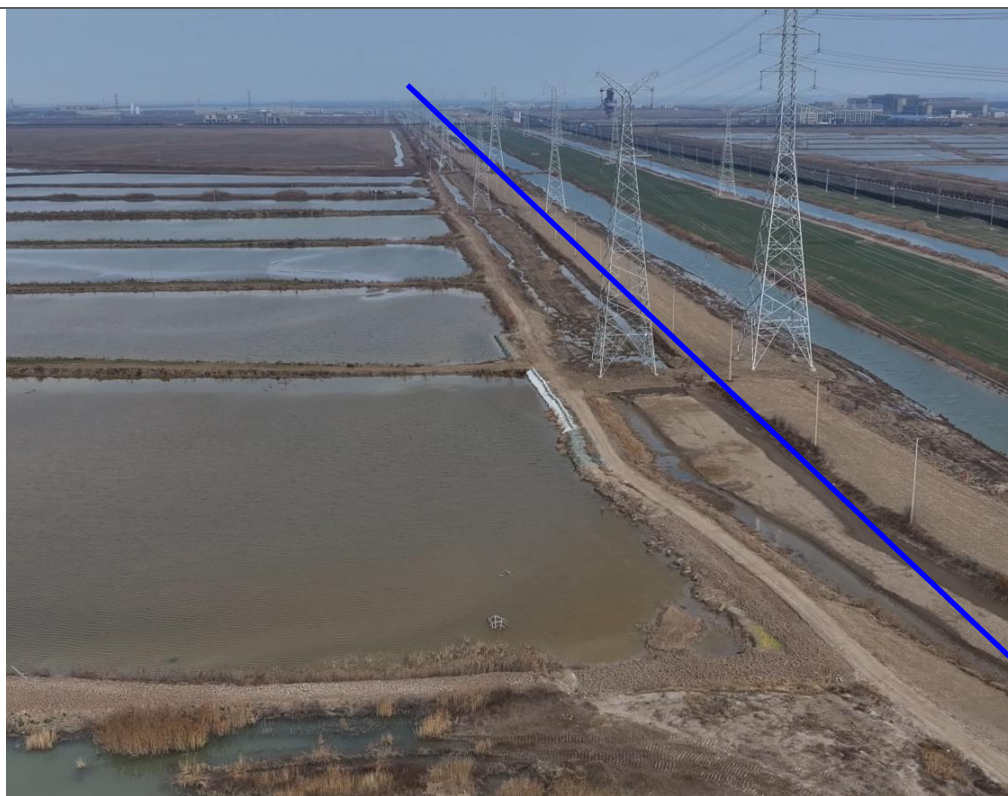
本项目架空线路（部分）
