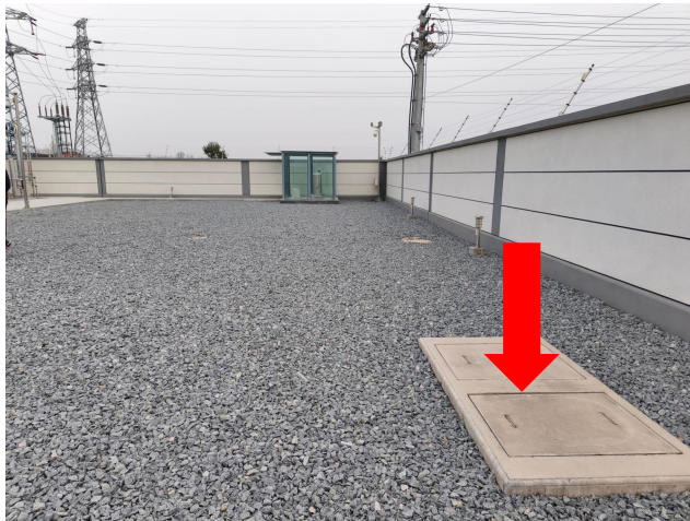
洪爽 110kV 变电站事故油池
