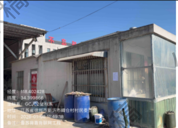
嶂仓村粮食收储厂房
