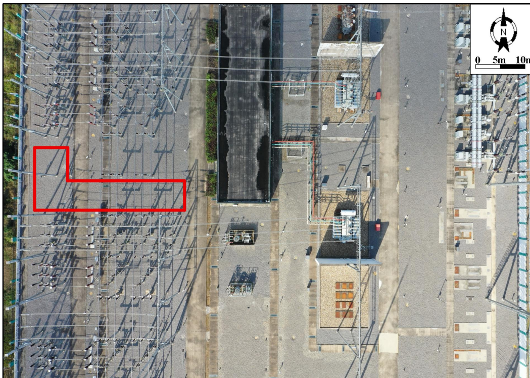
图 1.1-3 红密 220 千伏变电站 110 千伏间隔改造工程场地现状图 (2026.03)
