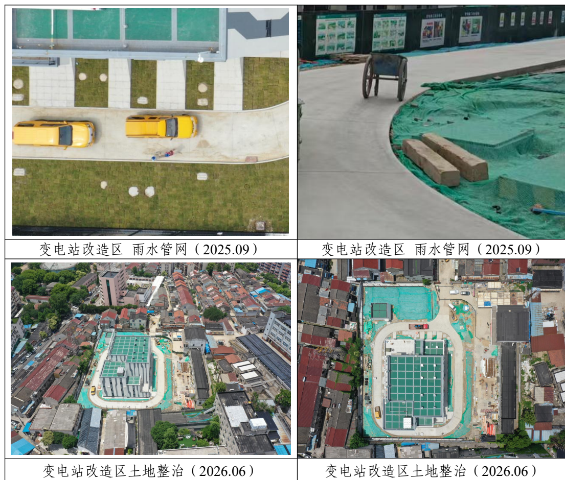
图 4-1 水土保持工程措施实施情况
