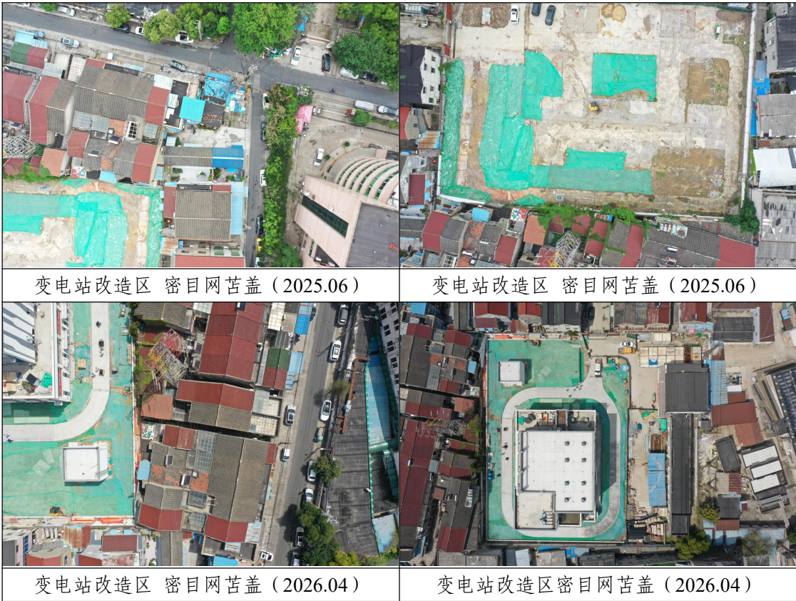
图 4-3 水土保持临时措施实施情况
