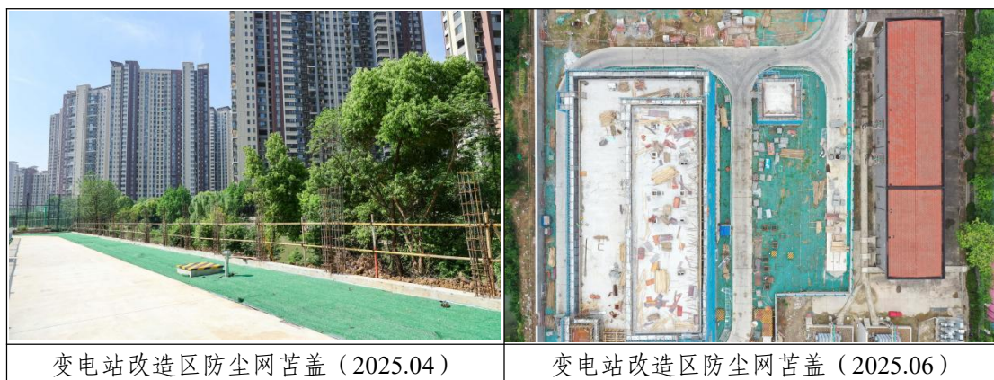
图 3-3 水土保持临时措施实施情况
