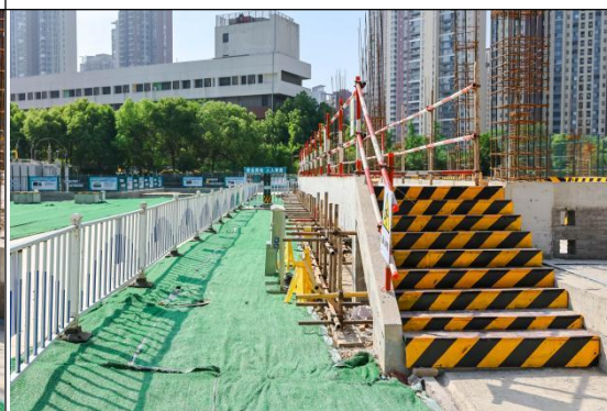
变电站改造区防尘网苫盖 (2025.04)
