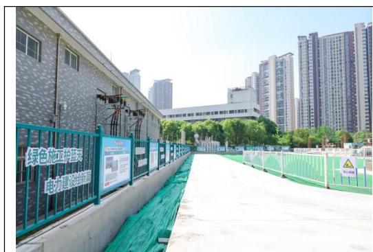
变电站改造区防尘网苫盖 (2025.04)
