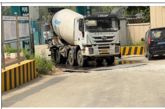
变电站改造区洗车平台 (2024.08)
