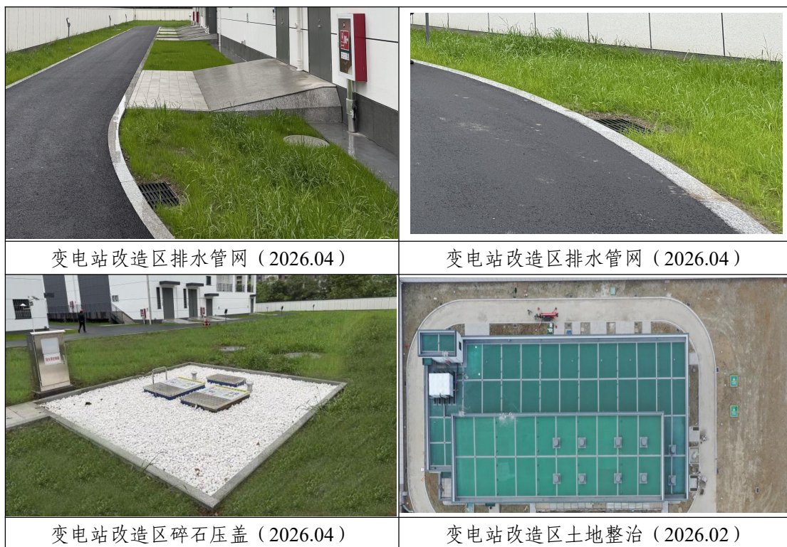
图 3-1 水土保持工程措施实施情况
