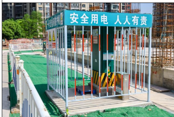
变电站改造区防尘网苫盖 (2025.04)
