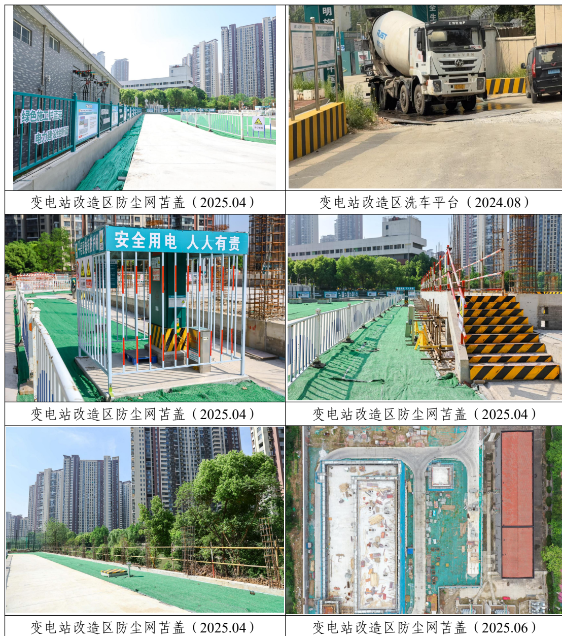
图 4-3 水土保持临时措施实施情况
