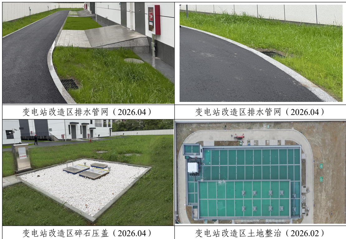
图 4-1 水土保持工程措施实施情况
