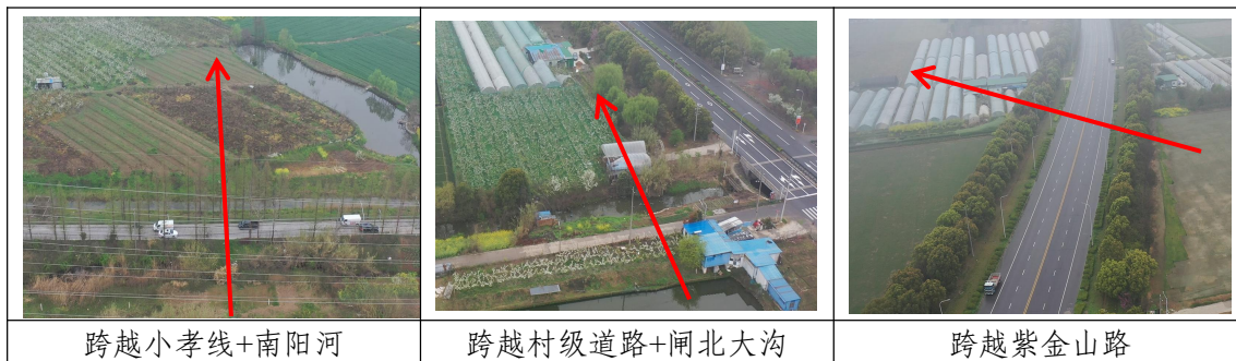
图 1.1-4 本工程架空线路跨越情况照片
