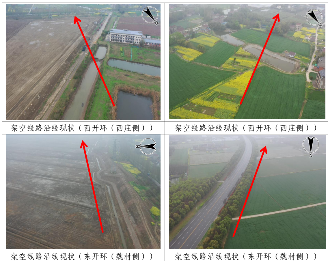
图 1.1-2 本工程线路沿线现状照片
