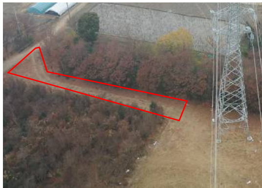
施工临时道路区 撒播草籽 (2026年1月)
