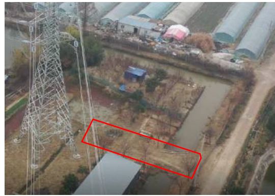
施工临时道路区 复耕 (2026年1月)
