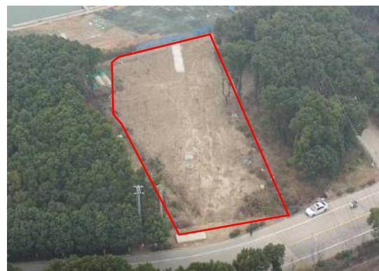
电缆施工区 撒播草籽 (2026 年 1 月)
