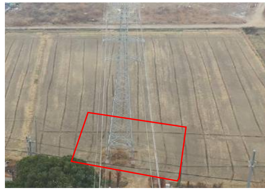
塔基区 13# 复耕 (2026 年 1 月)
