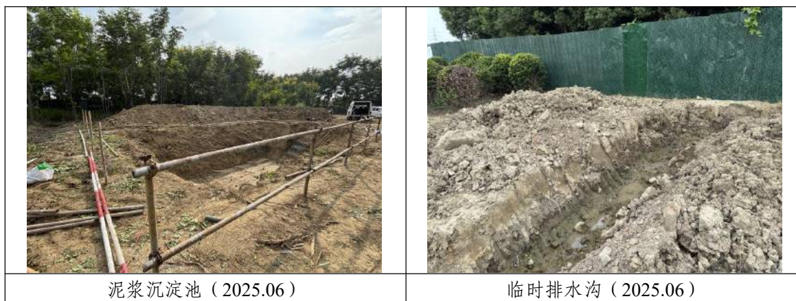
图 4-3 水土保持临时措施实施情况
