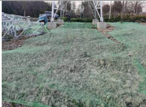
塔基区密目网苫盖（2025年9月）
