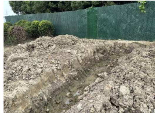
临时排水沟 (2025年6月)
