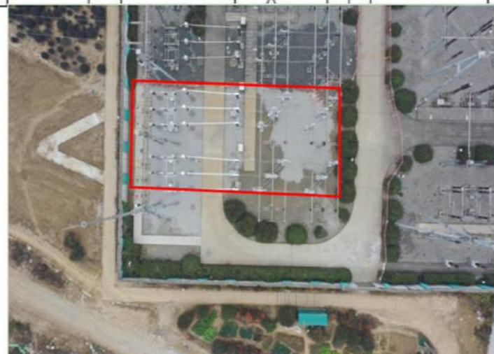
水土保持工程措施实施情况一览表
