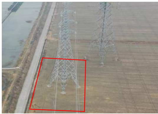
塔基区 10# 复耕 (2026 年 1 月)
