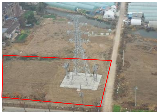
塔基区 6# 复耕 (2026 年 1 月)
