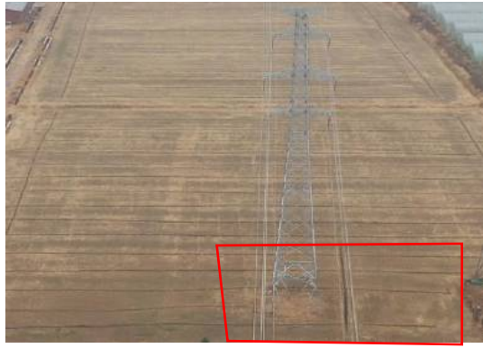
塔基区 8# 复耕 (2026 年 1 月)
