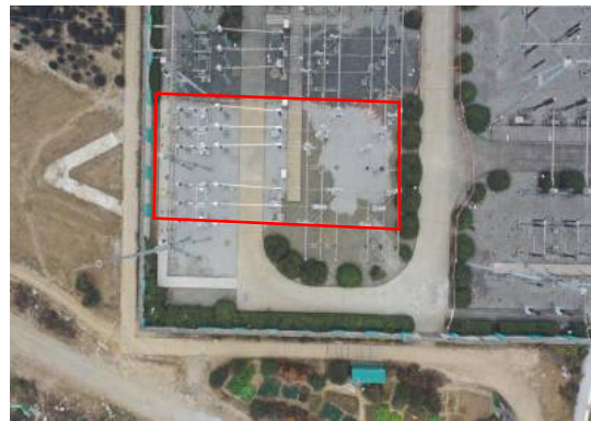
间隔扩建区碎石压盖 (2026年1月)
