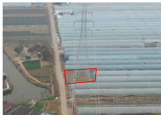
塔基区 7# 复耕 (2026 年 1 月)
