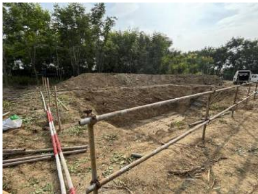
泥浆沉淀池 (2025年6月)
