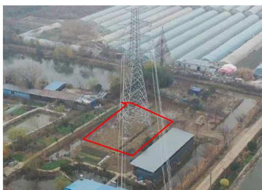
塔基区 3# 复耕 (2026 年 1 月)
