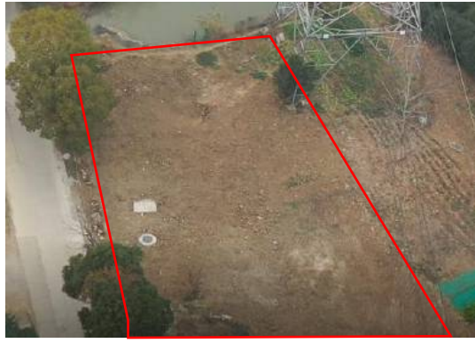
电缆施工区 复耕 (2026年1月)
