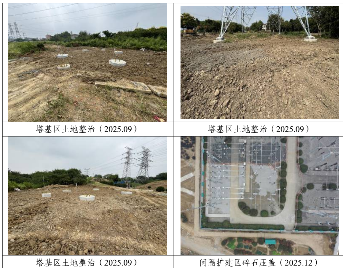
图 3-1 水土保持工程措施实施情况
