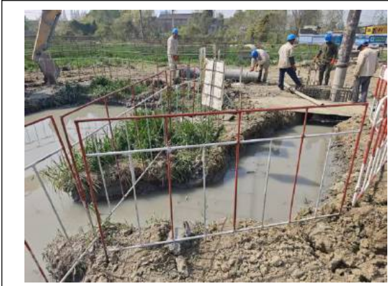
泥浆沉淀池（2025年6月）
