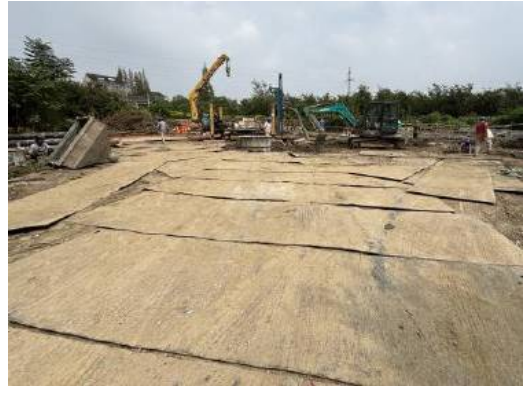
施工临时道路区铺设钢板（2025年9月）
