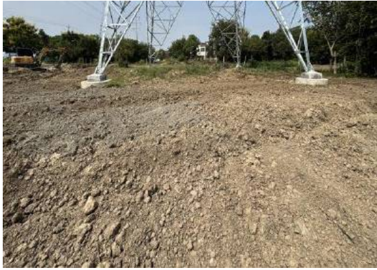
塔基区土地整治（2025年9月）
