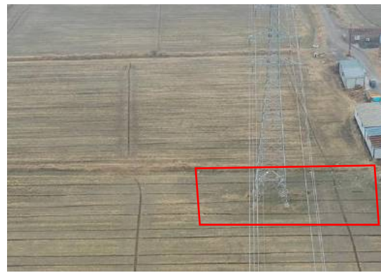
塔基区 11# 复耕 (2026 年 1 月)
