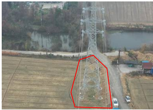
塔基区 12# 复耕 (2026 年 1 月)
