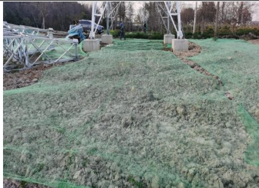
塔基区密目网苫盖（2025年9月17日）
