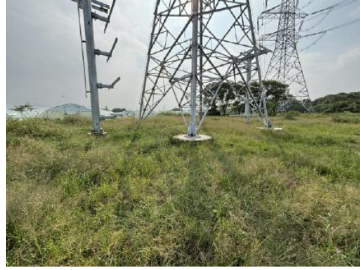
塔基区撒播草籽（2025年9月14日）
