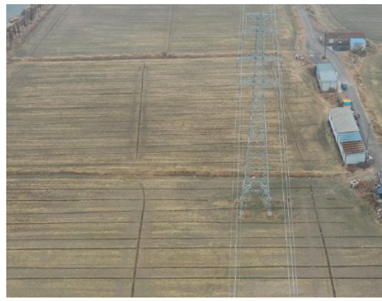
塔基区复耕（2026年1月20日）
