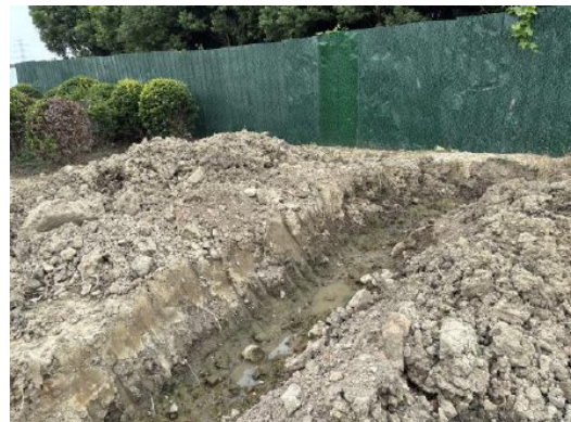
临时排水沟（2025年6月21日）
