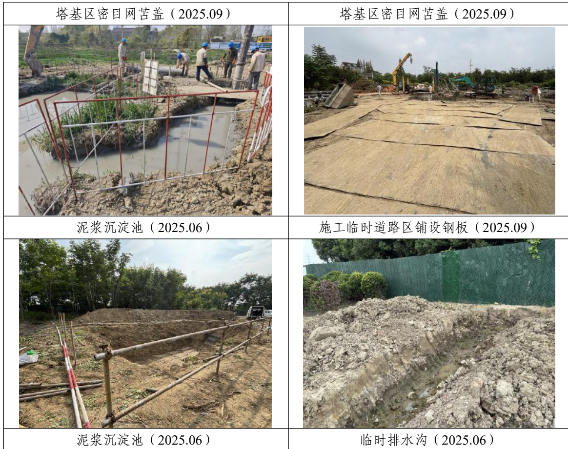
图 4-3 水土保持临时措施实施情况
