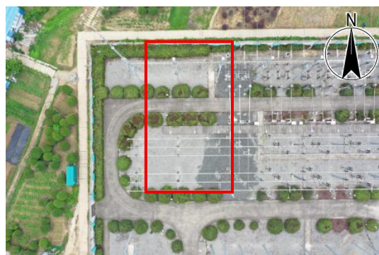
间隔扩建区施工前影像（2025.6）
