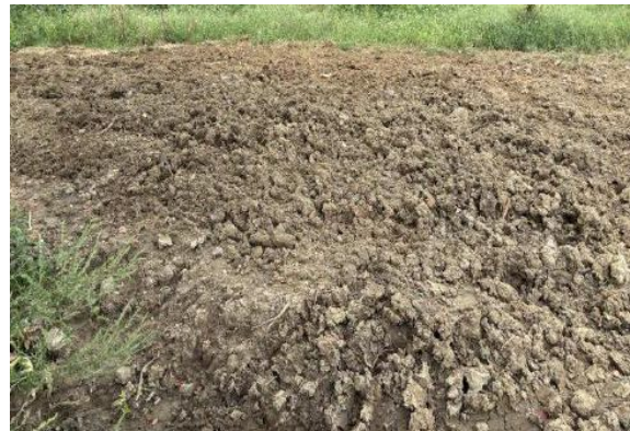
塔基区土地整治（2025年9月14日）
