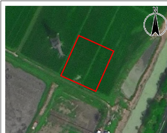
塔基区施工前影像（2024.10）
