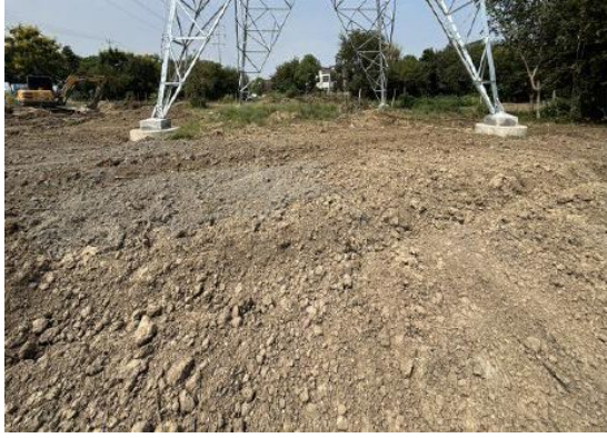
塔基区土地整治（2025年9月14日）
