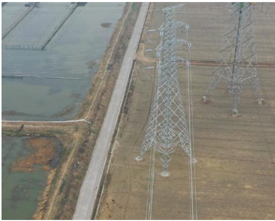
塔基区复耕（2026年1月20日）
