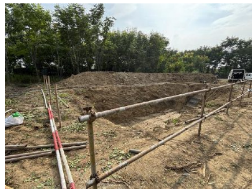
泥浆沉淀池（2025年6月21日）
