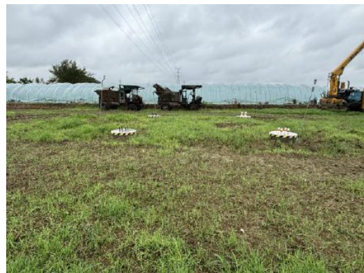
塔基基础（2025年6月21日）
