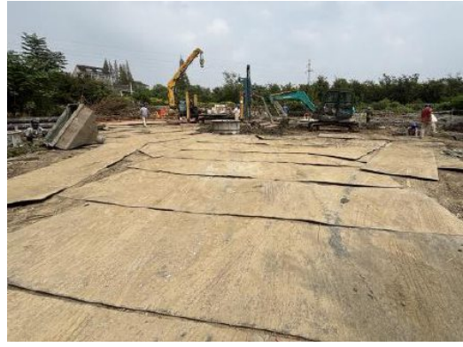
施工临时道路区铺设钢板 (2025年9月14日)
