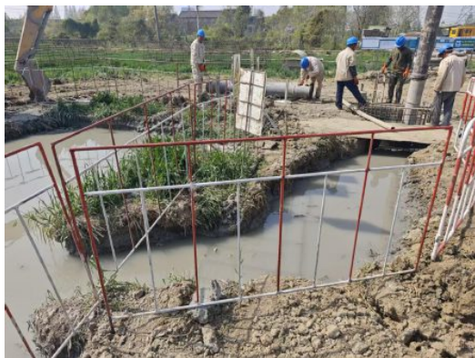
泥浆沉淀池（2025年6月21日）
