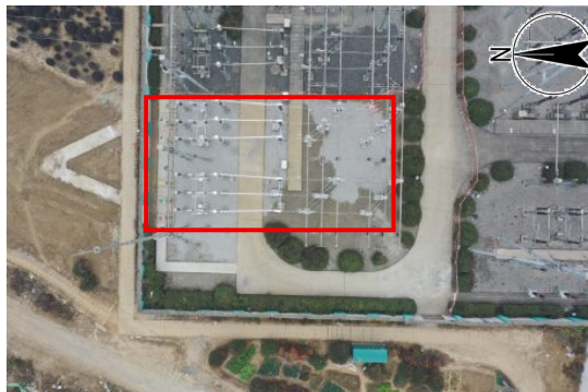
间隔扩建区施工后影像（2026.01）
