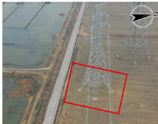
塔基区施工后影像（2026.01）
