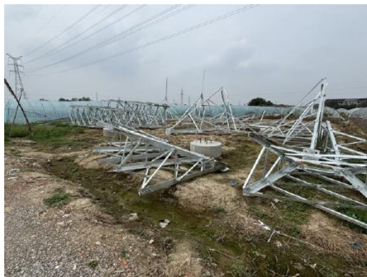
塔基区组塔 (2025年9月14日)
