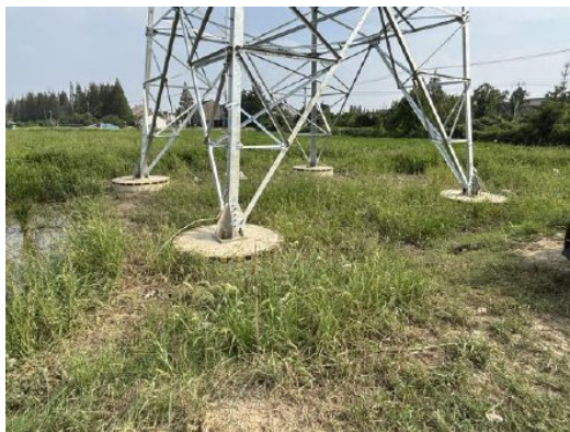
塔基区撒播草籽 (2025年9月14日)
