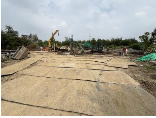
施工临时道路区铺设钢板
