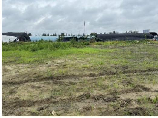
塔基场地（暂未施工/2024年12月10日）
