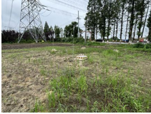
塔基基础 (2025年6月21日)
