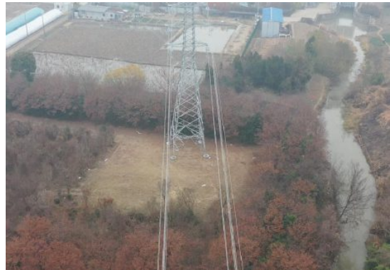
塔基区撒播草籽（2026年1月20日）
