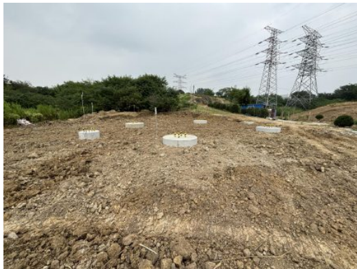
塔基区土地整治 (2025年9月14日)
