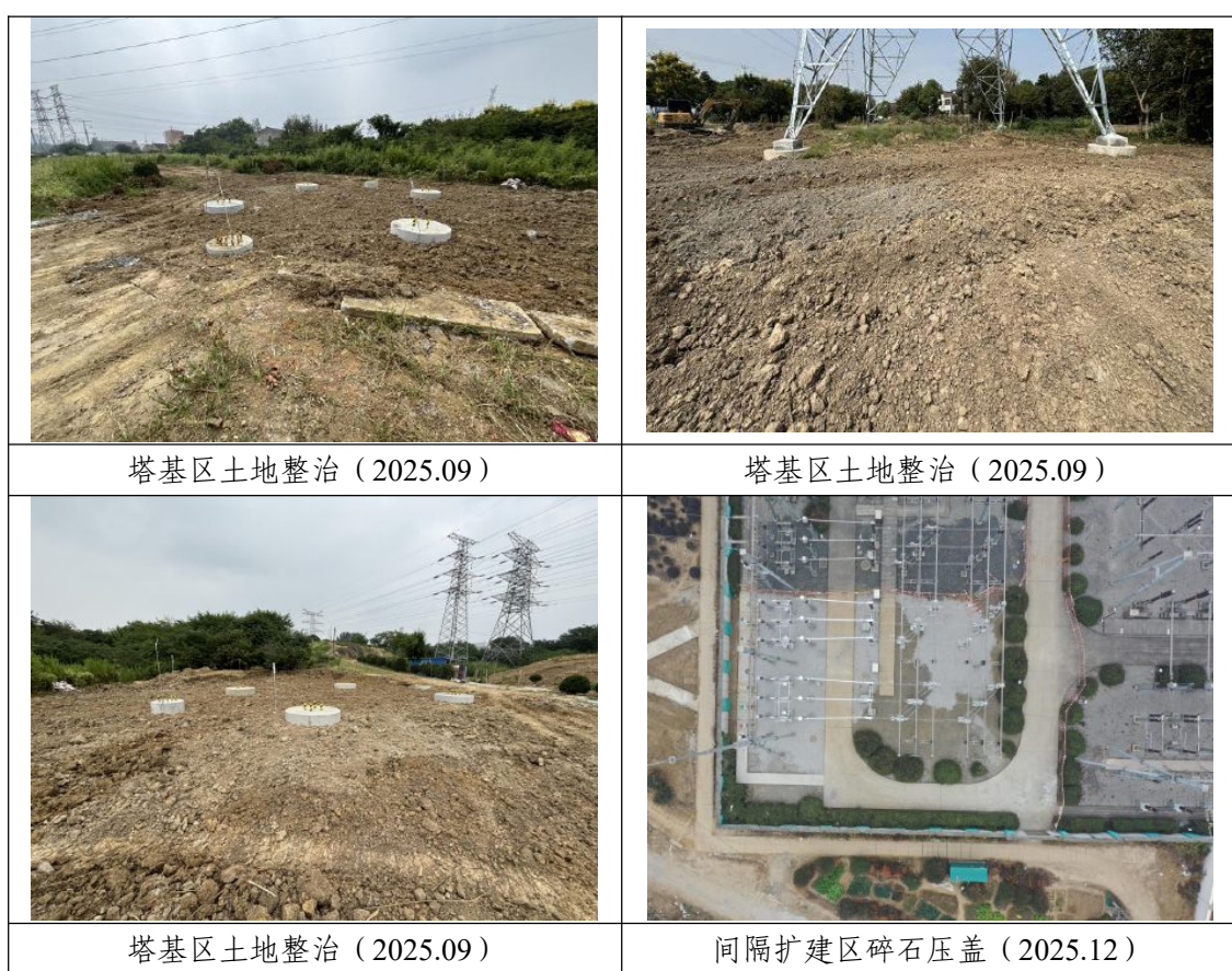
图 4-1 水土保持工程措施实施情况
