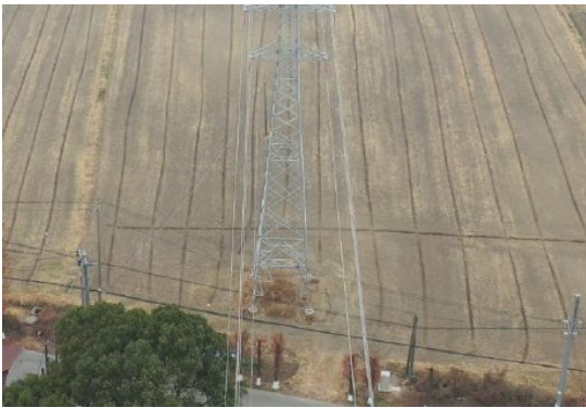
塔基区复耕（2026年1月20日）
