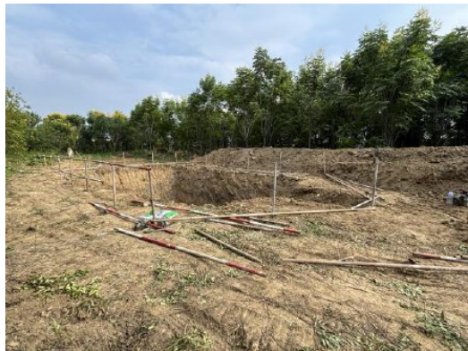
泥浆沉淀池 (2025年9月14日)
