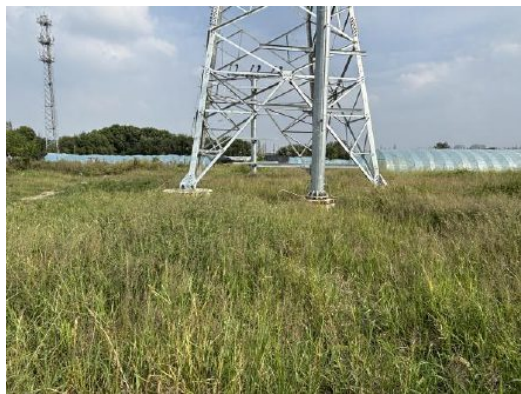
塔基区撒播草籽（2025年9月14日）
