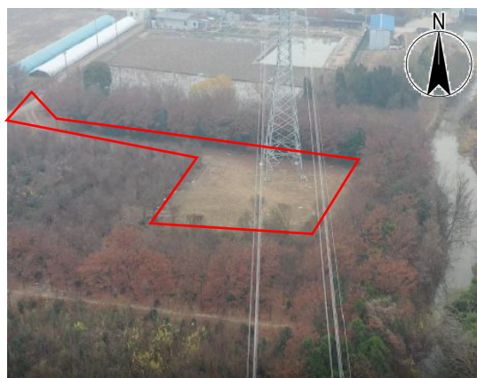
塔基区、施工临时道路区 施工后影像（2026.01）
