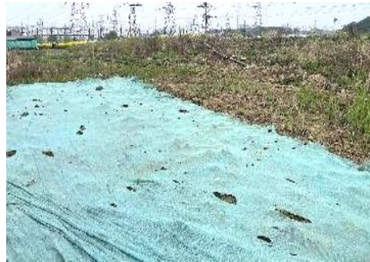
塔基区密目网苫盖（2025年9月）
