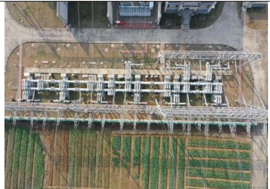
间隔扩建区 铺植草皮 (2026 年 1 月)
