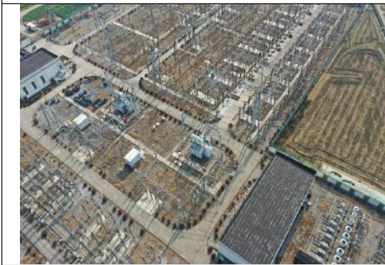
间隔改造区 碎石压盖 (2026 年 1 月)
