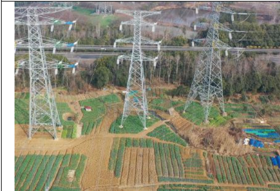
塔基区 11#复耕 (2026 年 1 月)
