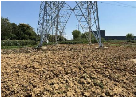
塔基区土地整治（2025年9月）
