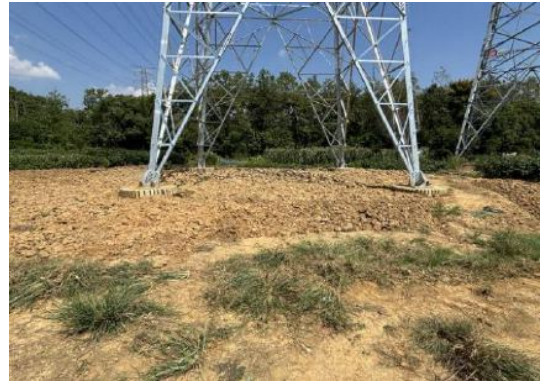
塔基区土地整治（2025年9月）
