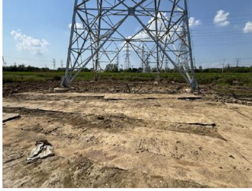
施工道路区铺设钢板（2025年9月）
