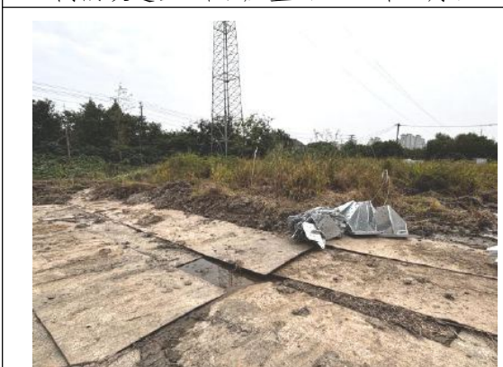
施工道路区铺设钢板 (2025 年 6 月)
