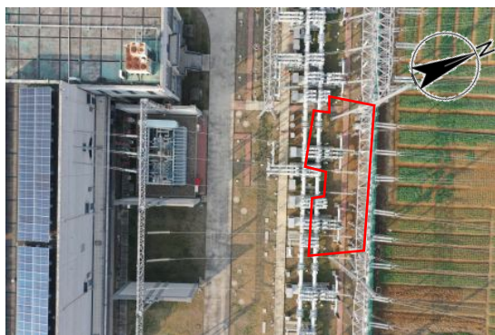
间隔扩建区施工后影像（2025.12）
