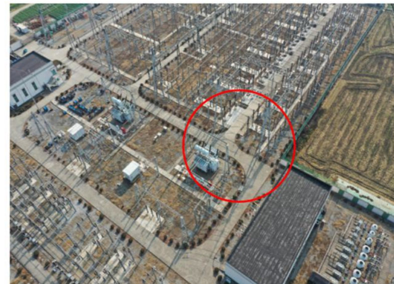
水土保持工程措施实施情况一览表
