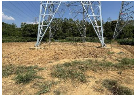
塔基区土地整治（2025年9月16日）
