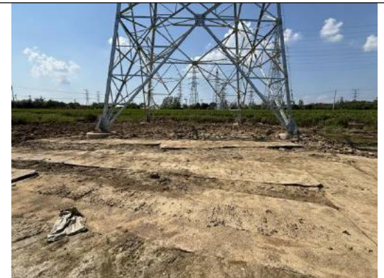
施工道路区铺设钢板 (2025.09)
