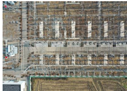
间隔改造区碎石压盖（2026年1月25日）
