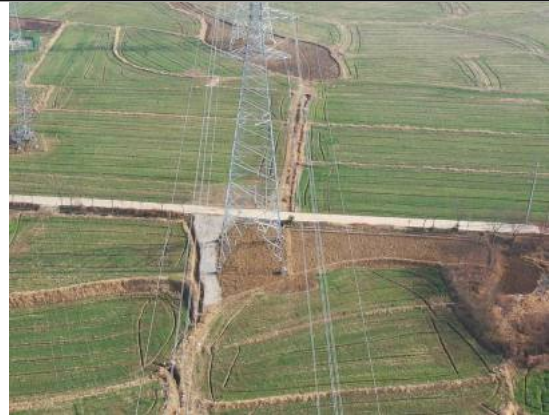
塔基区复耕（2026年1月25日）
