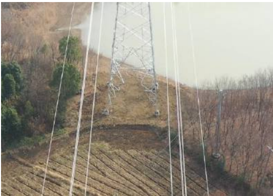
塔基区撒播草籽（2026年1月25日）
