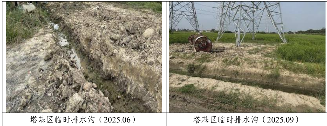
图 4-3 水土保持临时措施实施情况
