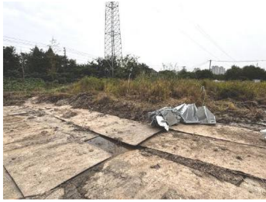
施工道路区铺设钢板（2025年6月24日）
