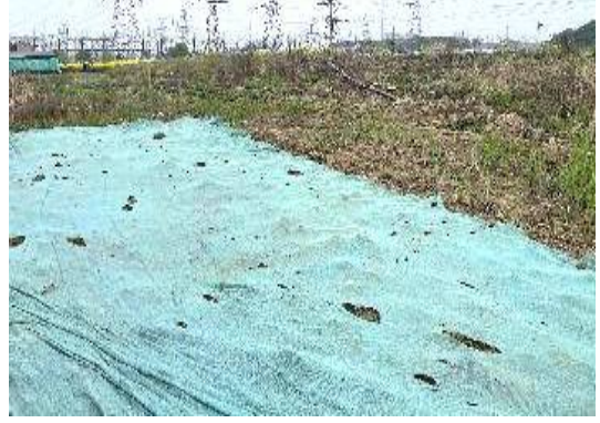
塔基区密目网苫盖（2025年9月22日）
