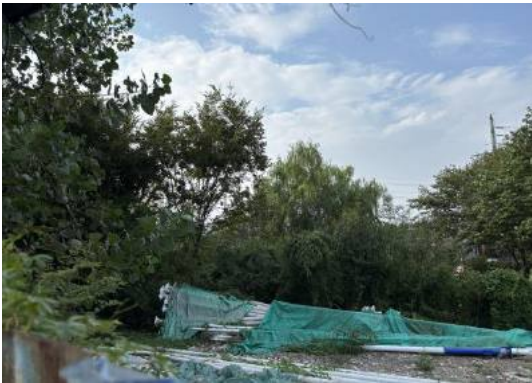
塔基区密目网苫盖（2025年9月22日）
