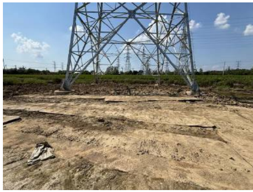
施工道路区铺设钢板（2025年9月16日）
