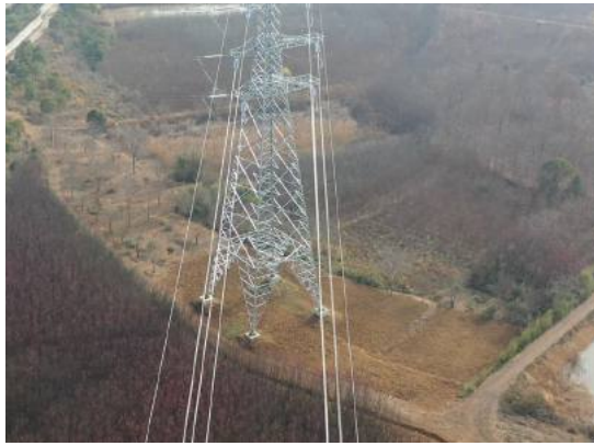
塔基区撒播草籽（2026年1月25日）
