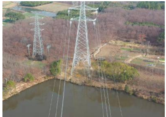
塔基区撒播草籽（2026年1月25日）
