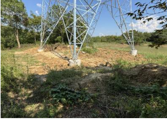
塔基区撒播草籽（2025年9月16日）
