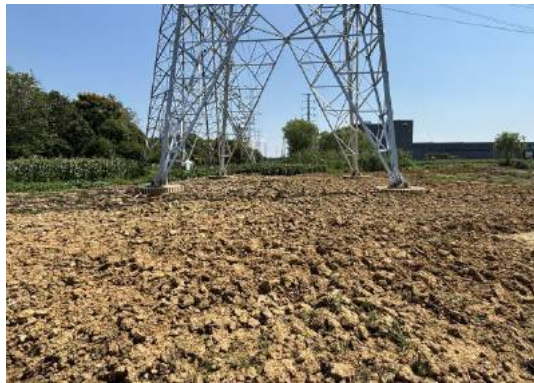
塔基区土地整治（2025年9月16日）
