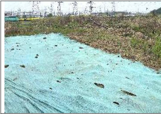
塔基区密目网苫盖 (2025.09)
