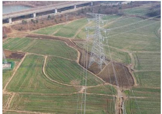
塔基区、施工道路区、牵张场复耕 （2026年1月25日）
