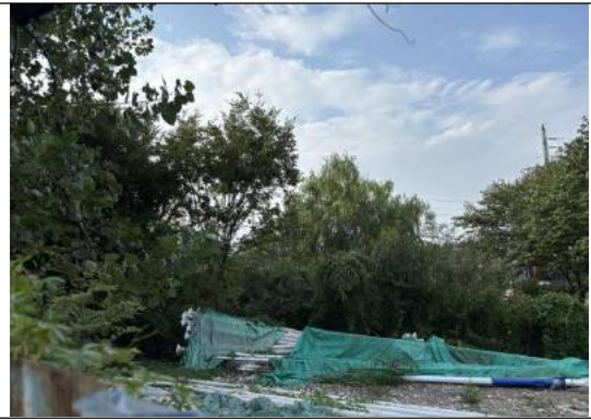
塔基区密目网苫盖 (2025.09)
