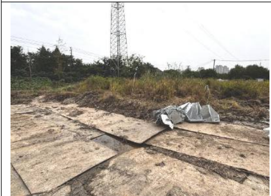
施工道路区铺设钢板 (2025.06)
