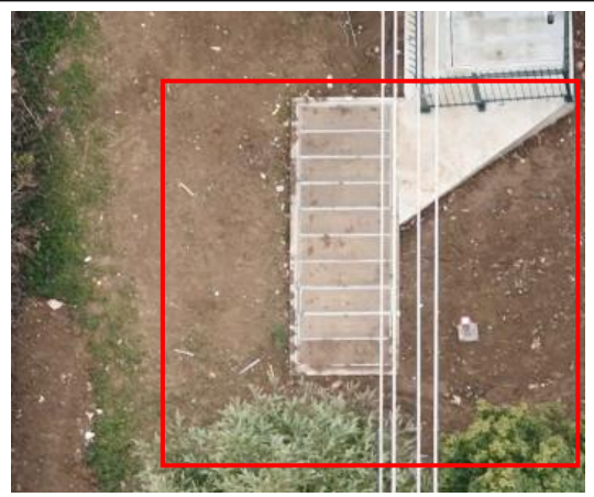
电缆施工区 撒播草籽 (2026.3)
