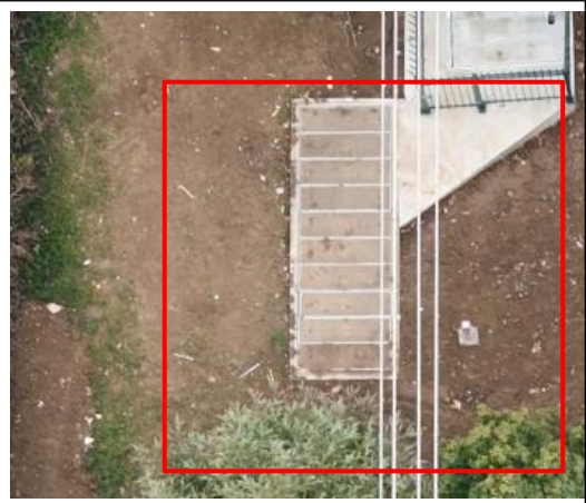
电缆施工区 撒播草籽 (2026.3)
