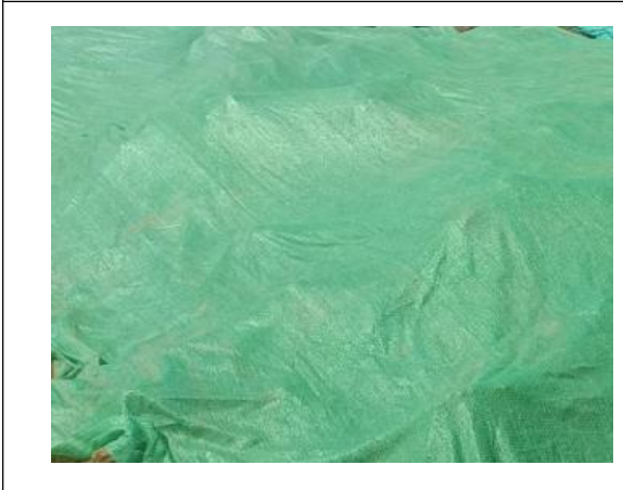
电缆施工区密目网苫盖 (2025.11)
