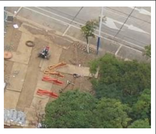
施工道路区 铺设钢板 (2025.11)
