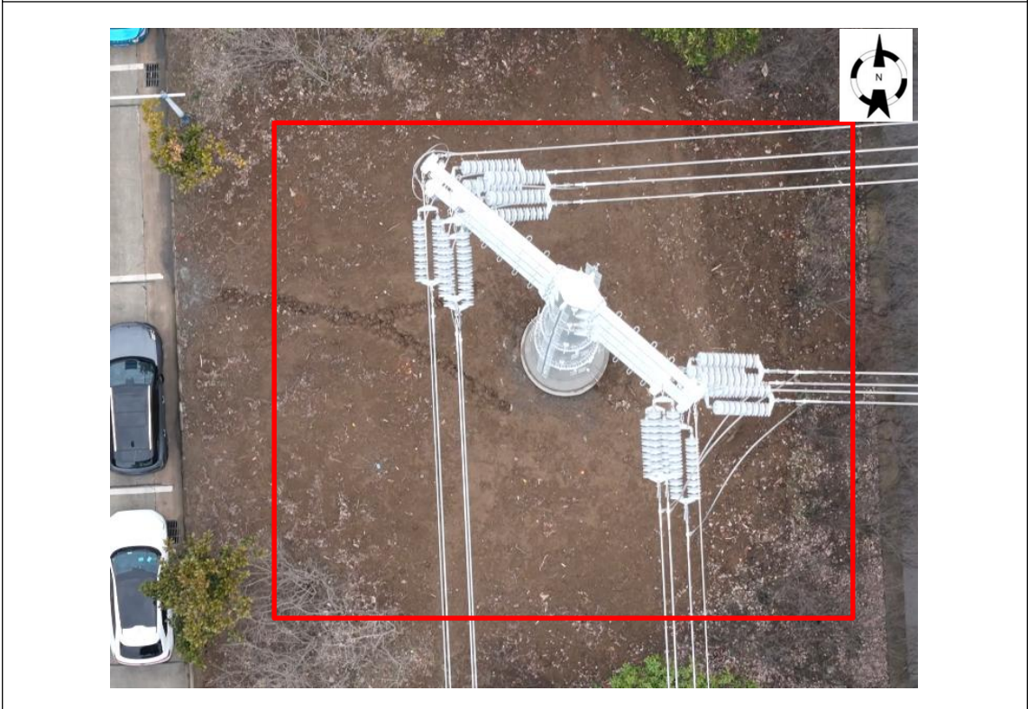
塔基区 撒播草籽 (2026.3)
