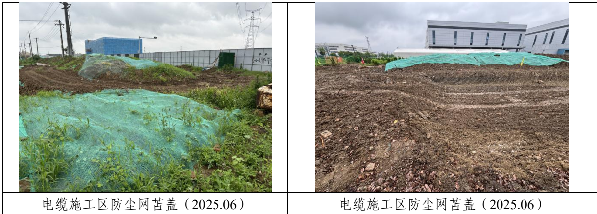
图 4-3 水土保持临时措施实施情况
