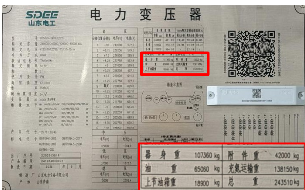
莫愁湖 220kV 变电站#3 主变铭牌（本期）
