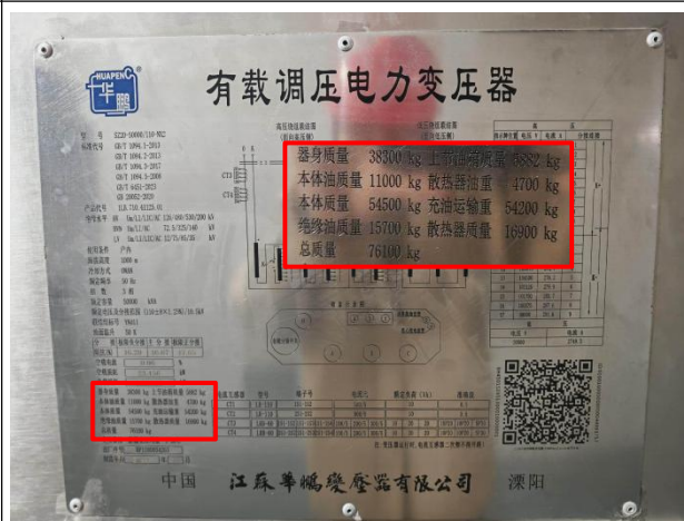
珠泉 110kV 变电站#2 主变铭牌 (主变额定容量 50MVA, 绝缘油重 15.7t)
