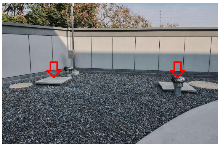
珠泉 110kV 变电站事故油池
