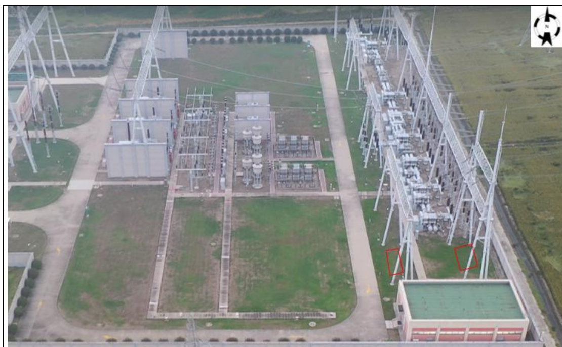
图 1.1-3 高邮 500 千伏变电站 220 千伏间隔改造工程场地现状图 (2025.10)
