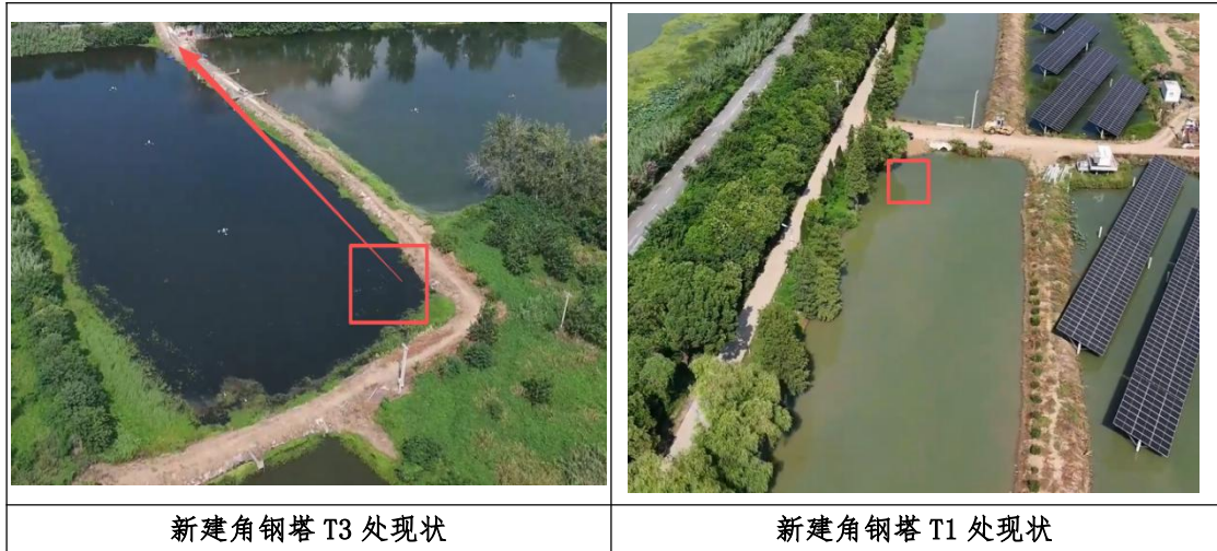
图 1.1-2 线路工程沿线现状照片
