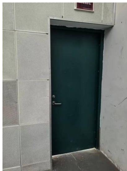
南站 220kV 变电站主变隔声门
