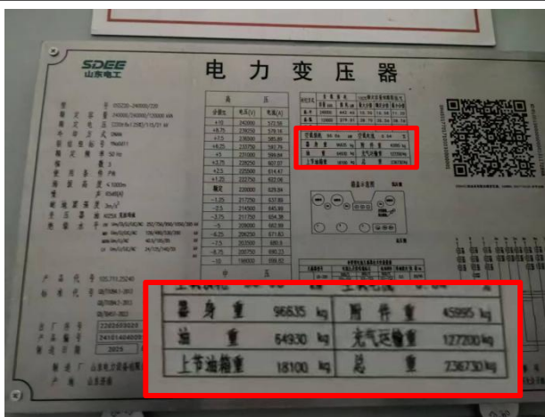
南站 220kV 变电站#2 主变铭牌（原有）
