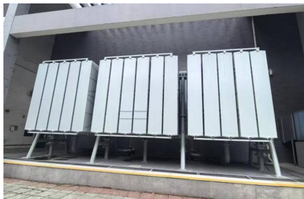
南站 220kV 变电站散热器
