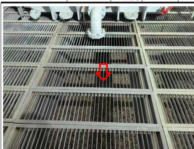
南站 220kV 变电站#1 主变事故油坑（原有）
