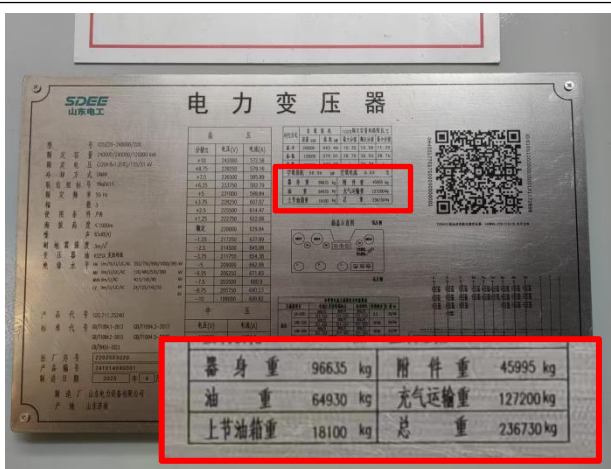
南站 220kV 变电站#3 主变铭牌（本期）
