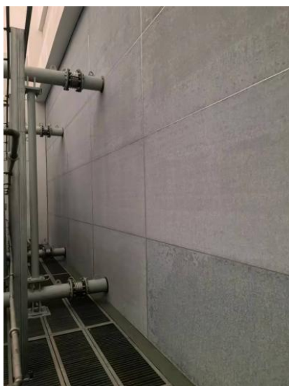
南站 220kV 变电站主变隔声墙
