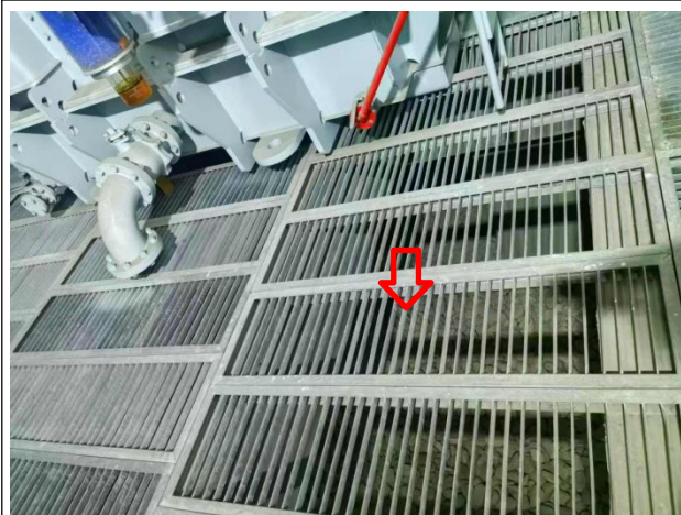
南站 220kV 变电站#2 主变事故油坑（原有）
