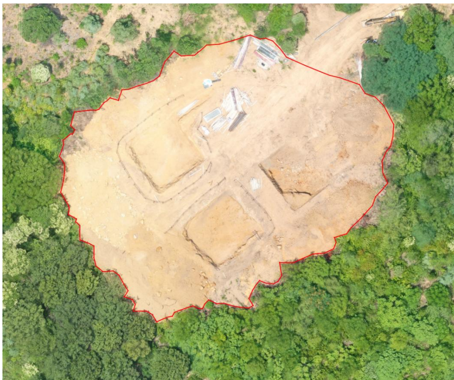
图 2-8 无人机航拍面积解译图（塔基区 N246）
