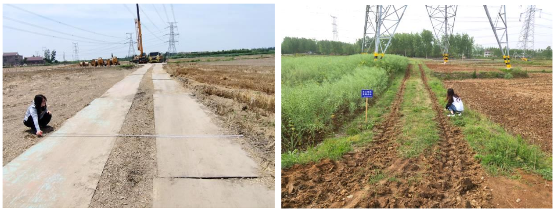
图 2-13 施工道路采用实地测量面积
