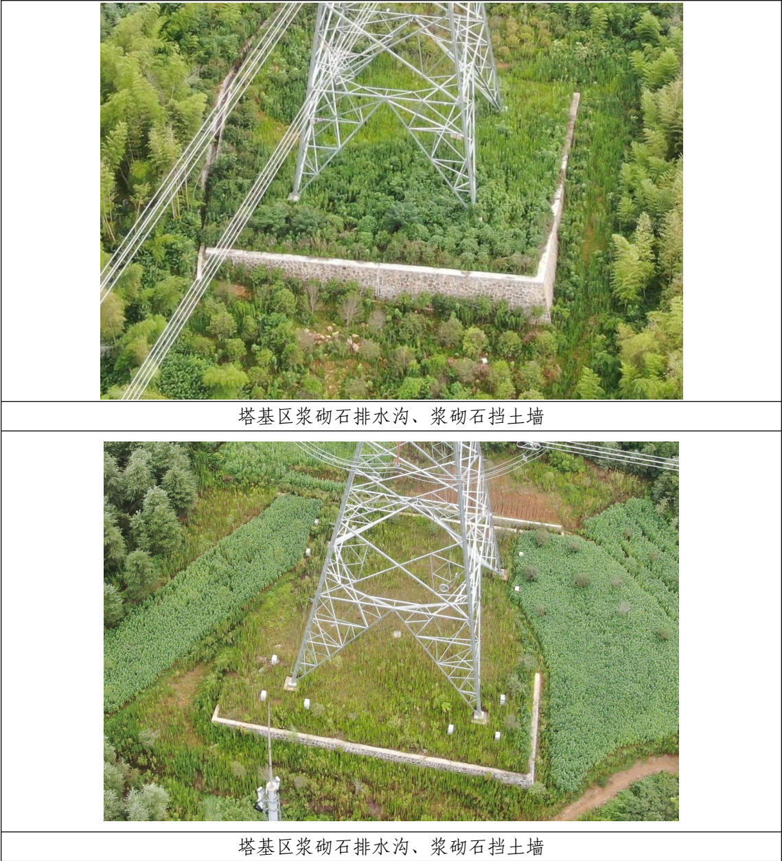
图 2-14 工程措施实施情况照片
