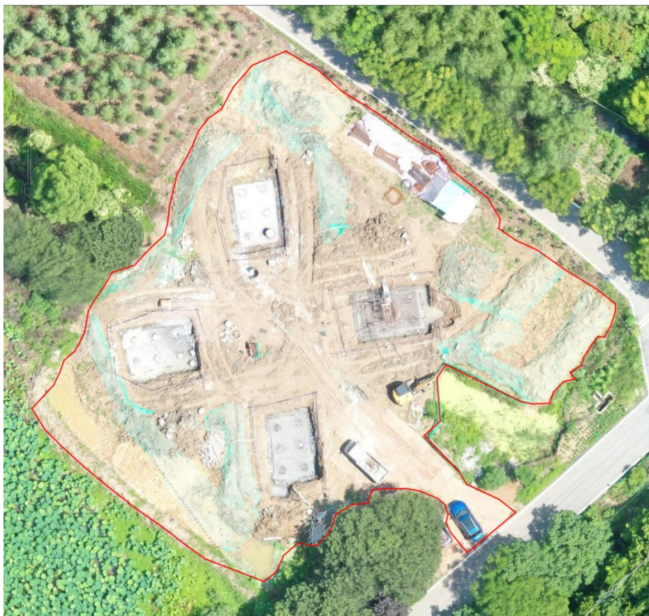
图 2-6 无人机航拍面积解译图（塔基区 N233）
