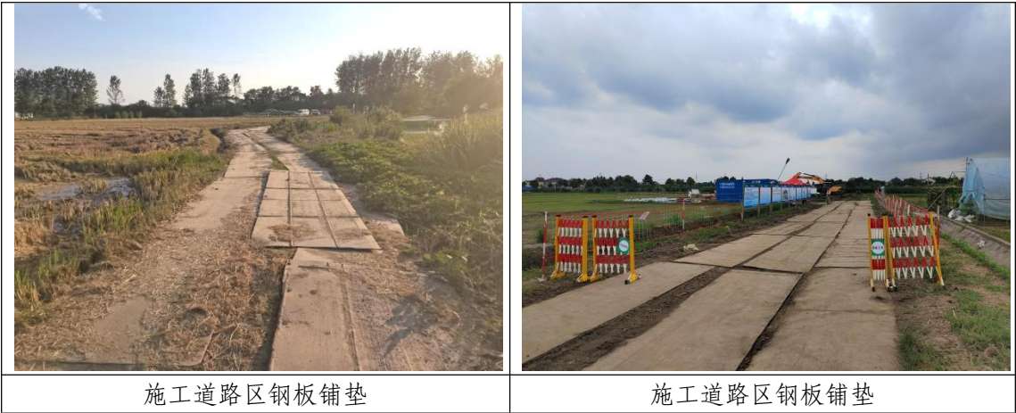
图 2-16 临时措施实施情况照片
