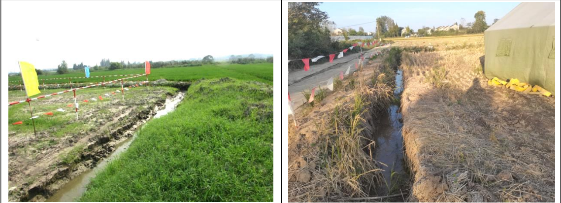
塔基区土质排水沟
