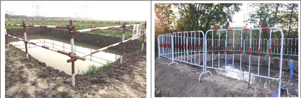
塔基区泥浆沉淀池
