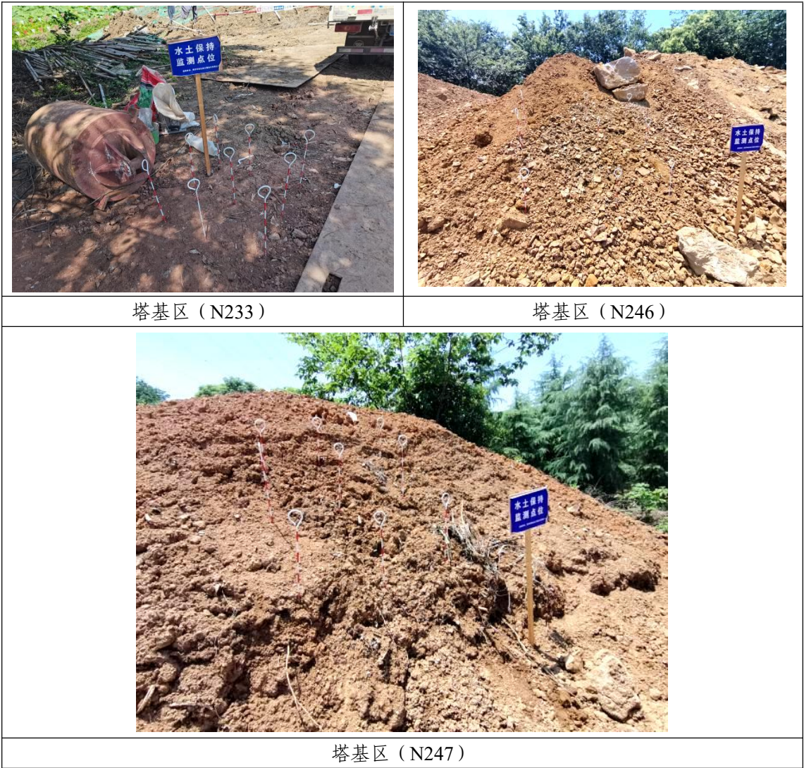
图 2-17 塔基区测钎法 监测点位照片
