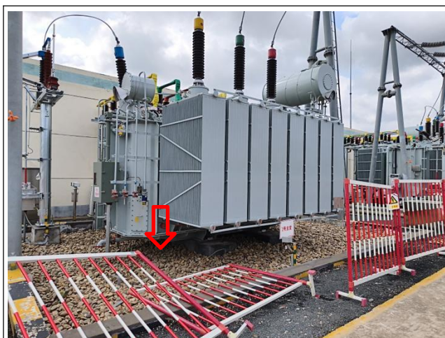
钟吾 110kV 变电站#1 主变压器、事故油坑
