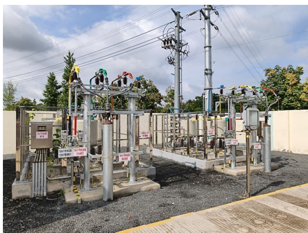
钟吾 110kV 变电站电容器组
