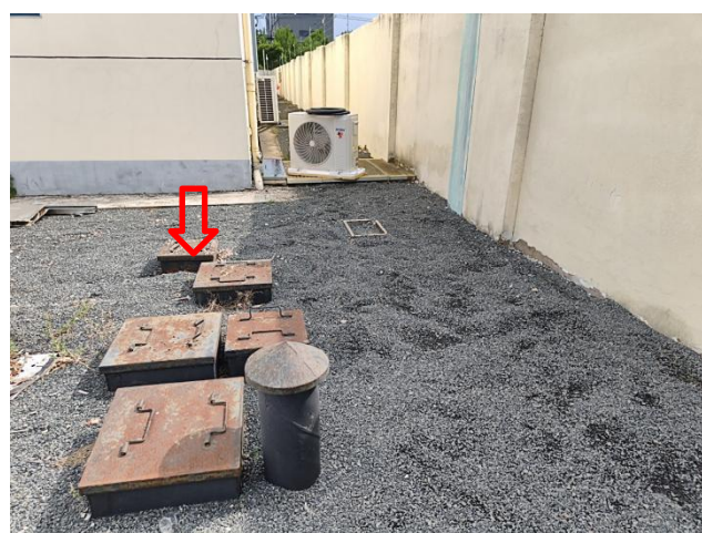
钟吾 110kV 变电站污水处理装置
