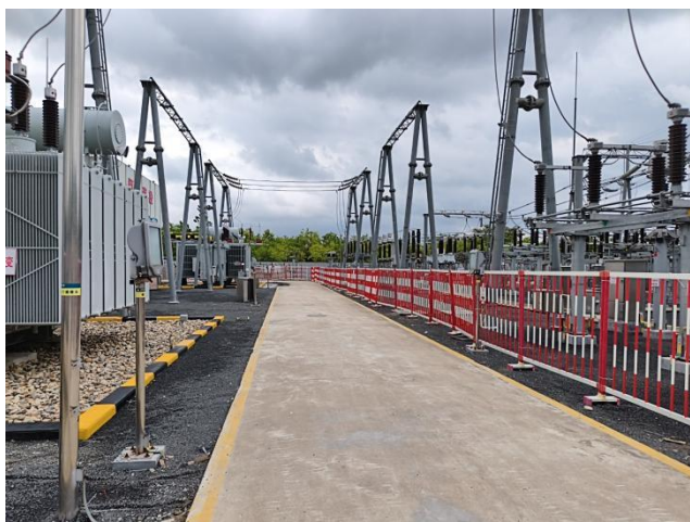
卓窑 110kV 变电站硬化道路及碎石铺盖
