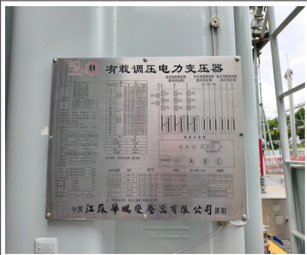
卓窑 110kV 变电站#1 主变铭牌
