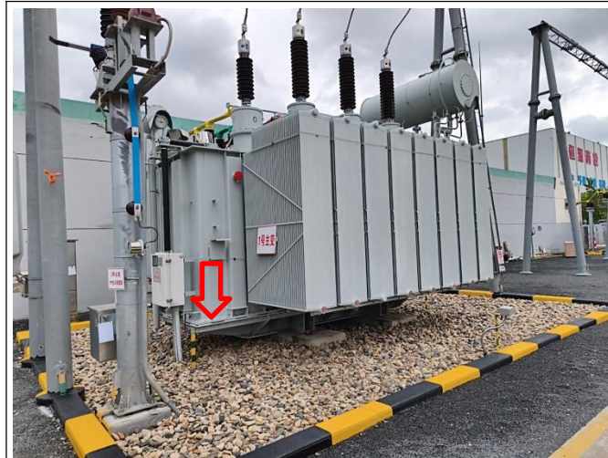
卓窑 110kV 变电站#1 主变压器、事故油坑
