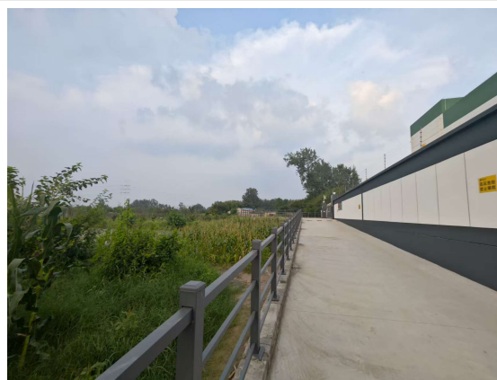
变电站北侧硬化及恢复
