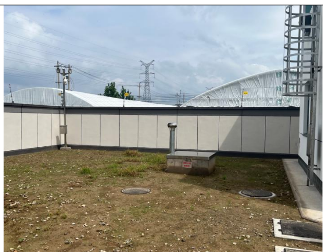
扩建围墙处恢复
