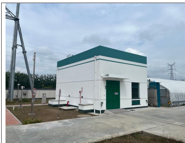
本期扩建水泵房
