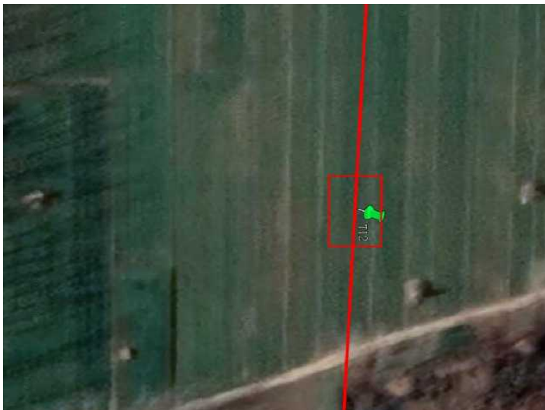
施工前（塔基区 T12、2024 年 1 月）
