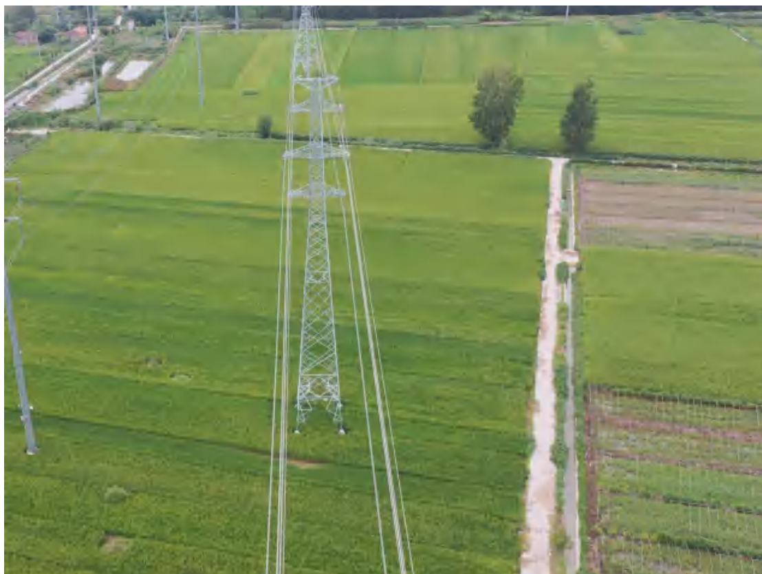
施工后（塔基区 T27、2025 年 8 月）
