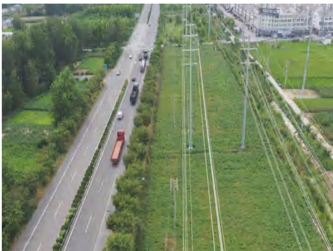
施工后（塔基区 T12、2025 年 8 月）
