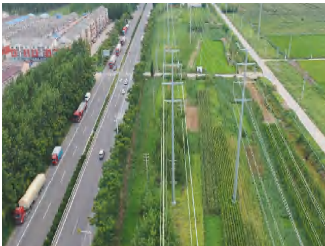
施工后（塔基区 T8、2025 年 8 月）
