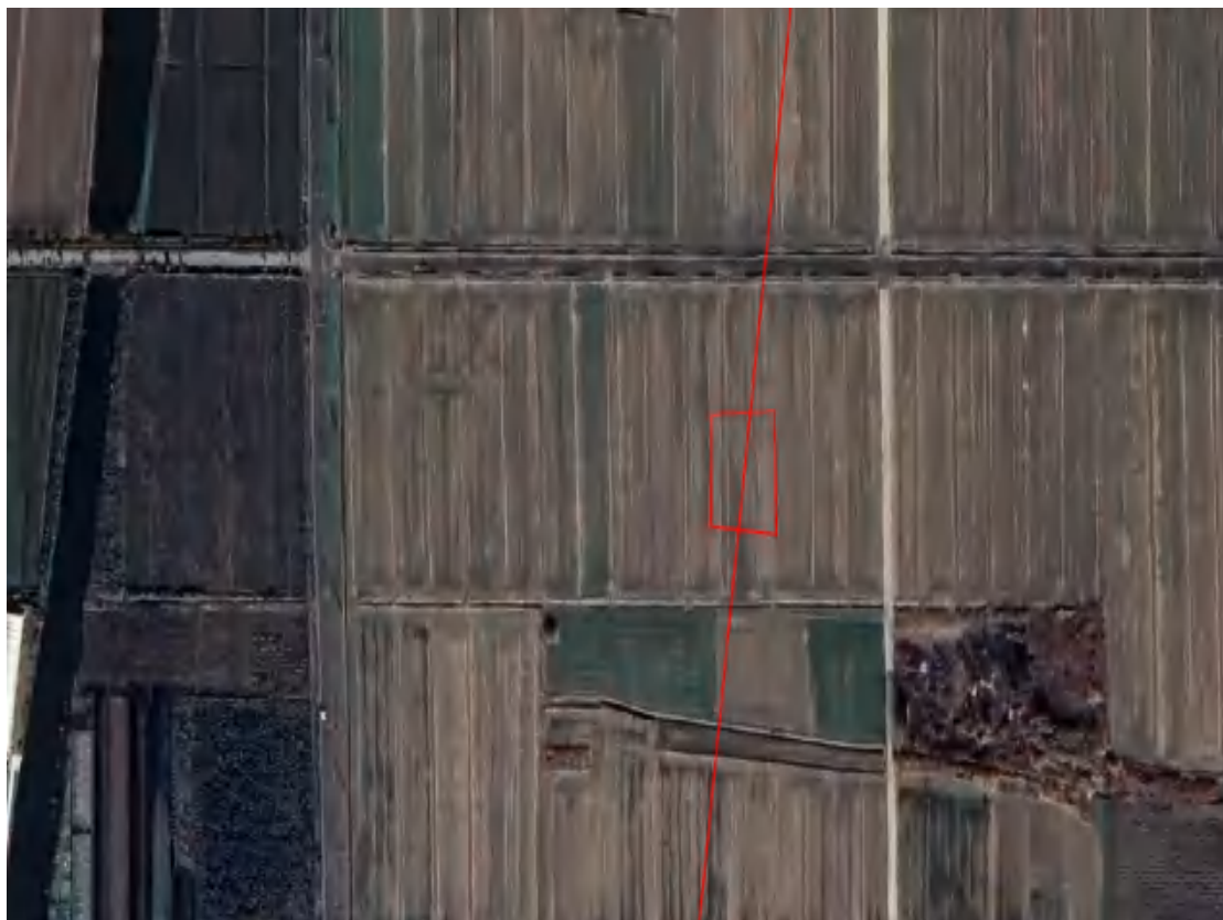
施工前（塔基区 T27、2024 年 1 月）
