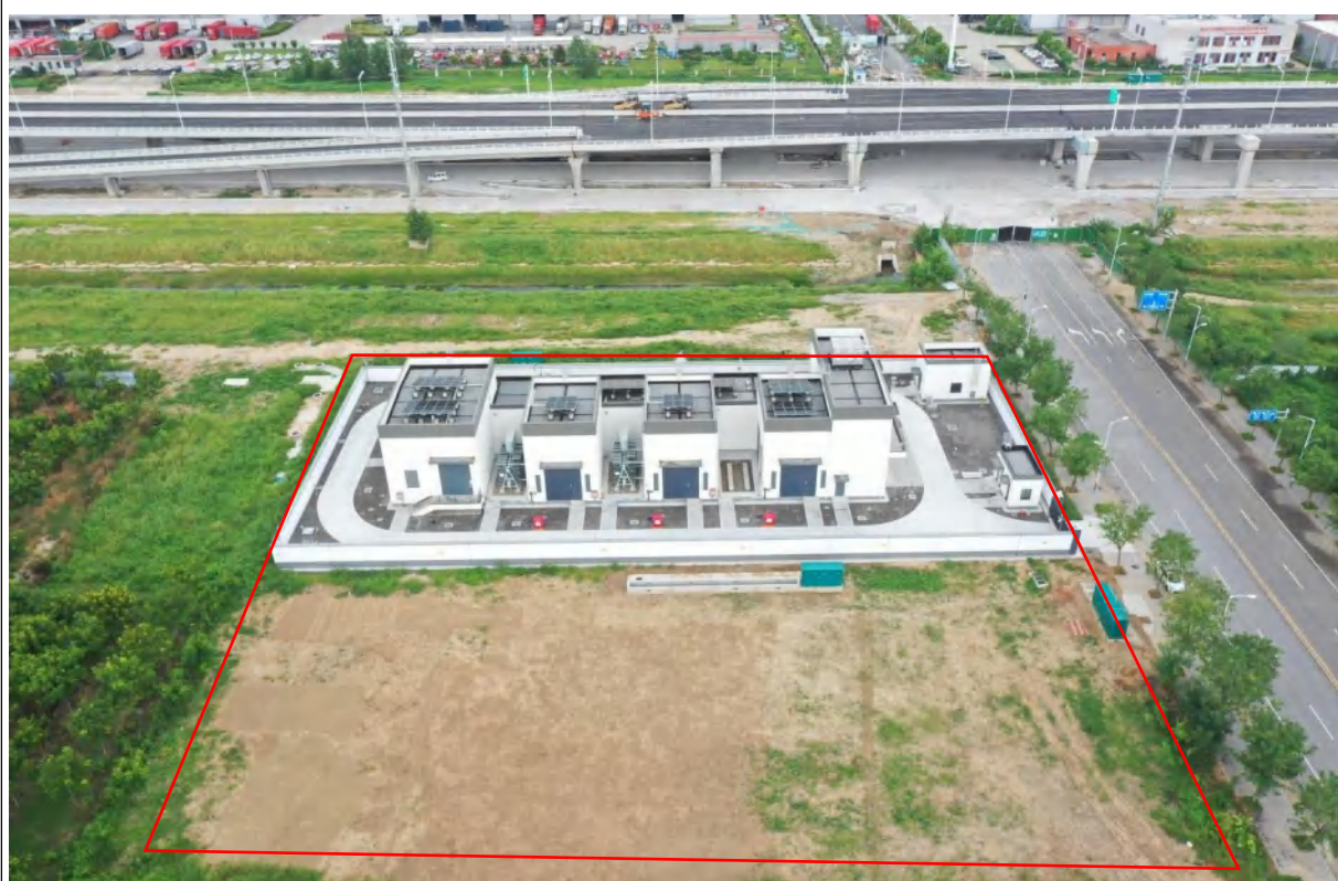
变电站区、施工生产生活区、临时堆土场区施工后期 2025 年 8 月
