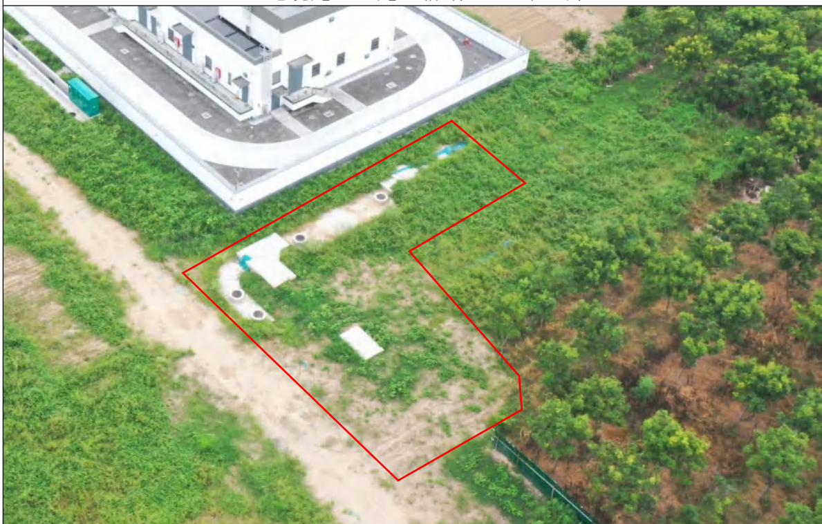
电缆施工区施工后期 2025 年 8 月
