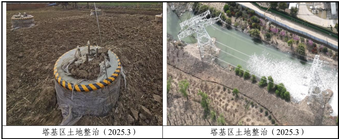
图 3.5-1 工程措施实施照片
