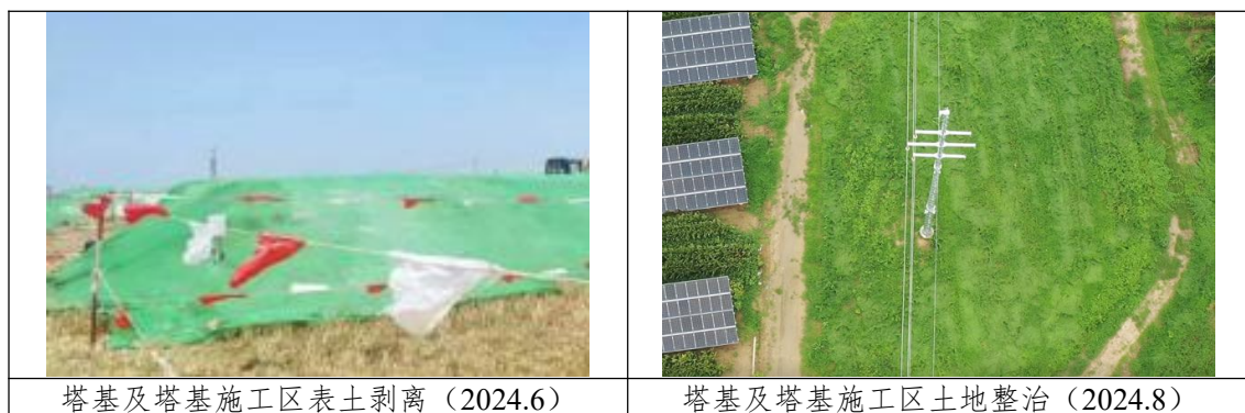
图 4-1 水土保持工程措施实施情况
