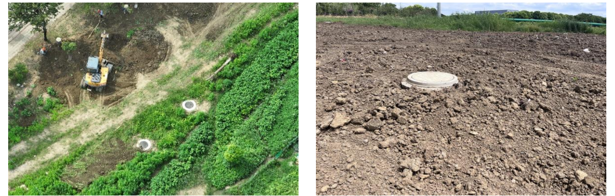
电缆施工区土地整治（2025.5）
