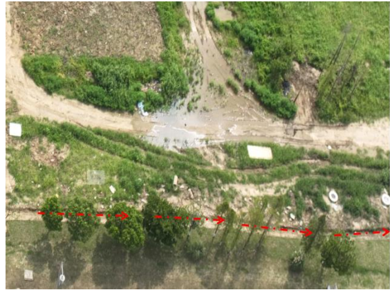
电缆施工区临时排水沟（2025.5）
