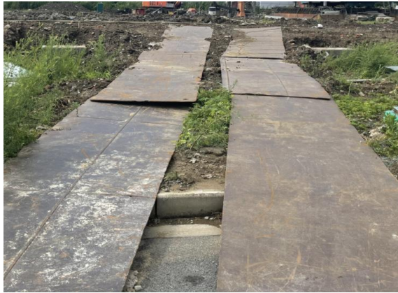
电缆施工区铺设钢板（2025.3）
