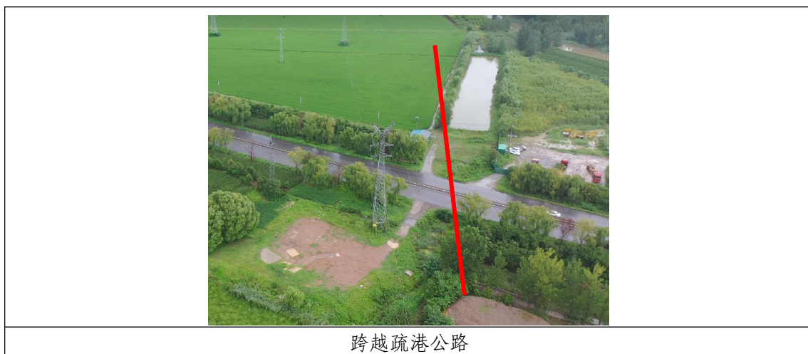
图 1.1-5 本工程架空线路跨越情况照片
