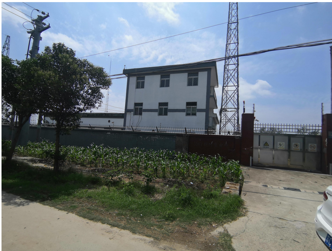
图 1-2 变电站现状图
