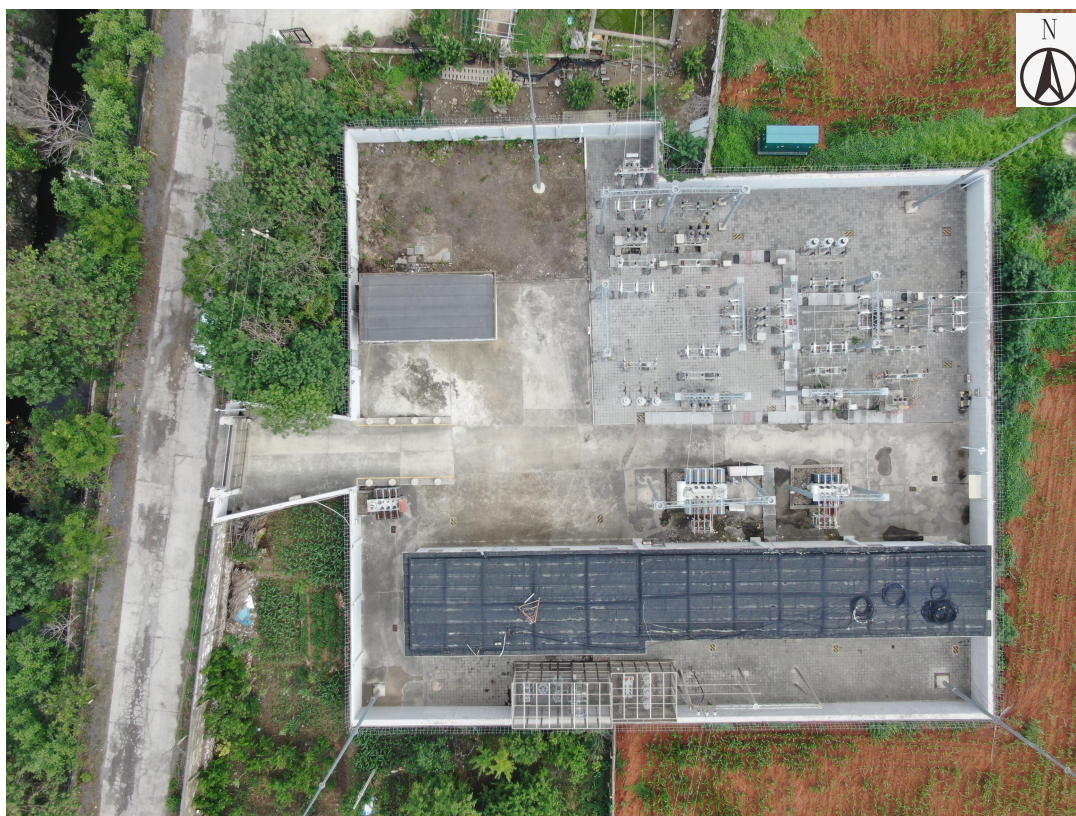
图 1-1 变电站现状图
