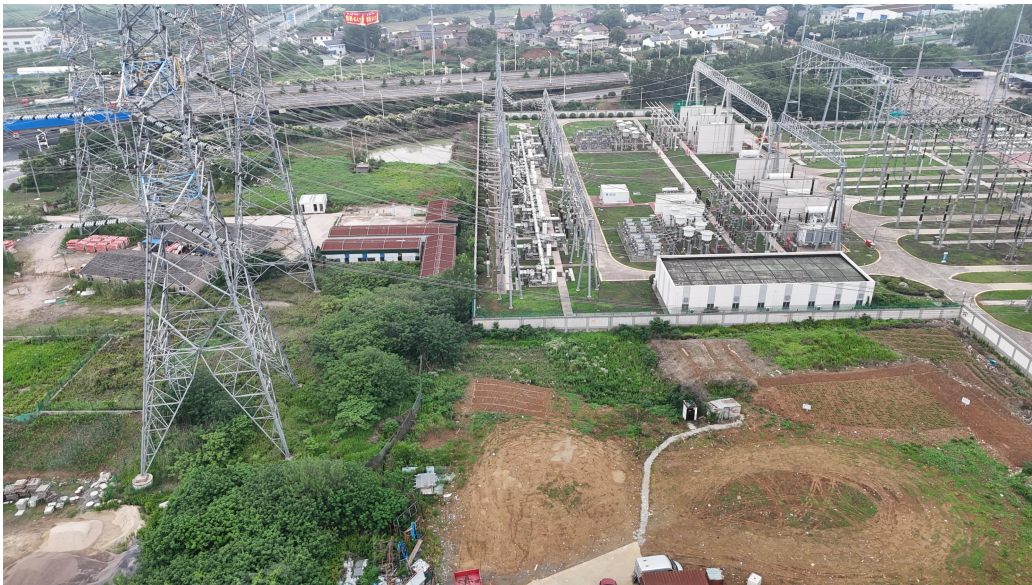
图 6-2 本工程临时占地恢复情况
