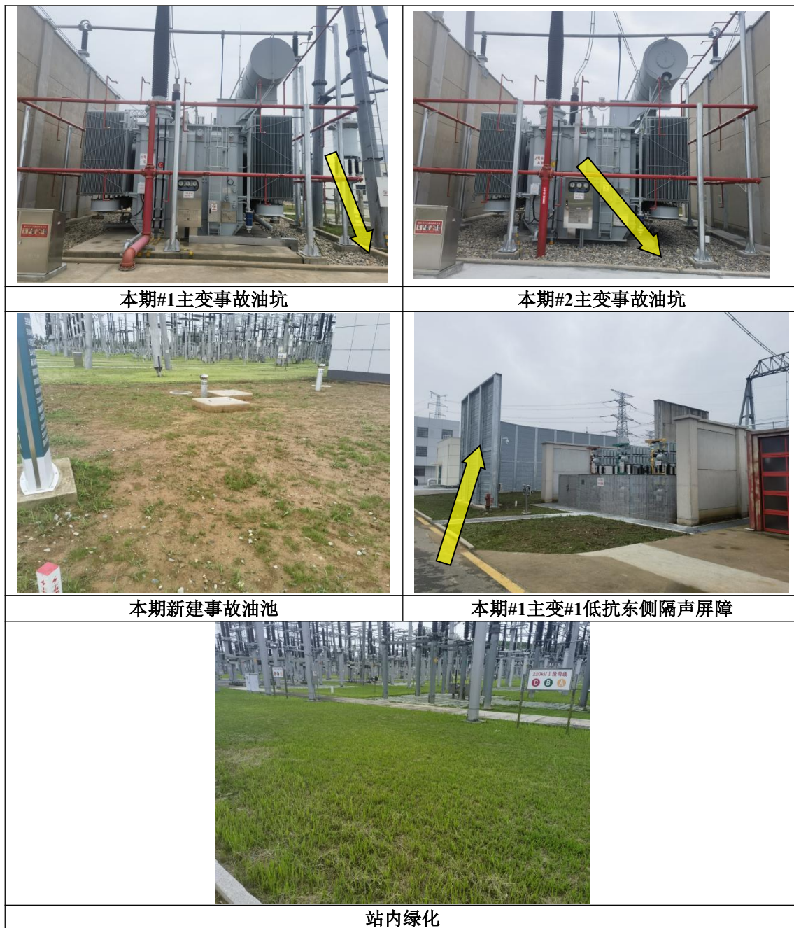
图3-4 上党500kV变电站本期工程环保措施
