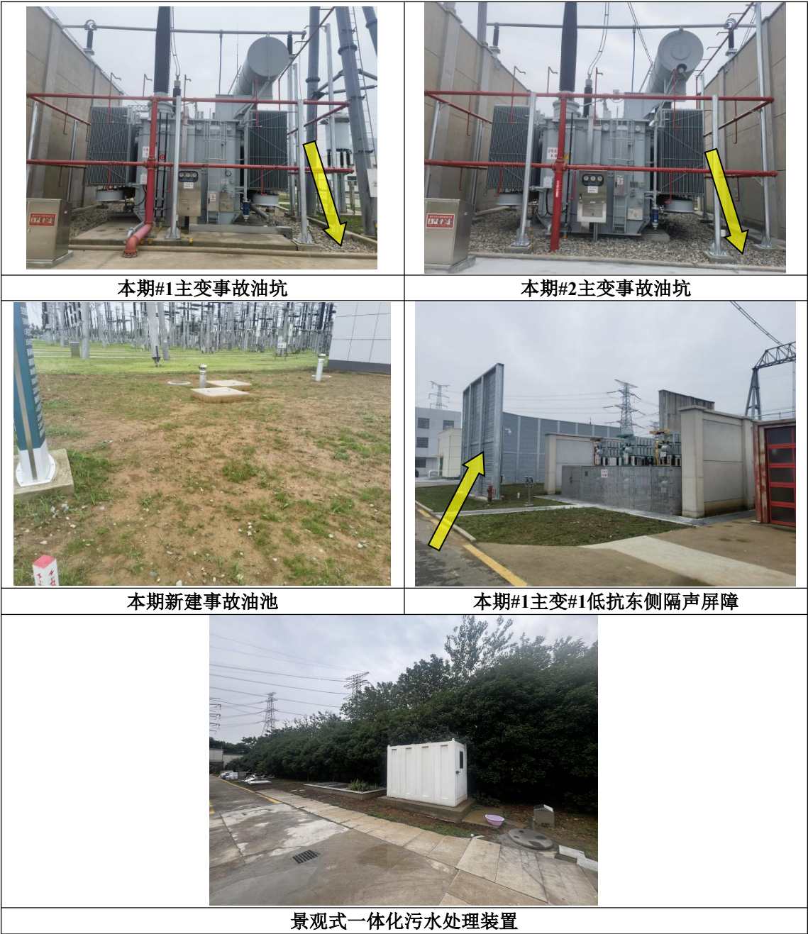
图 5-1 设计阶段环保措施落实情况照片
