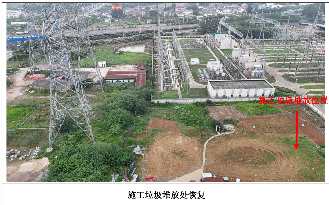
图 5-2 施工期环保措施落实情况照片
