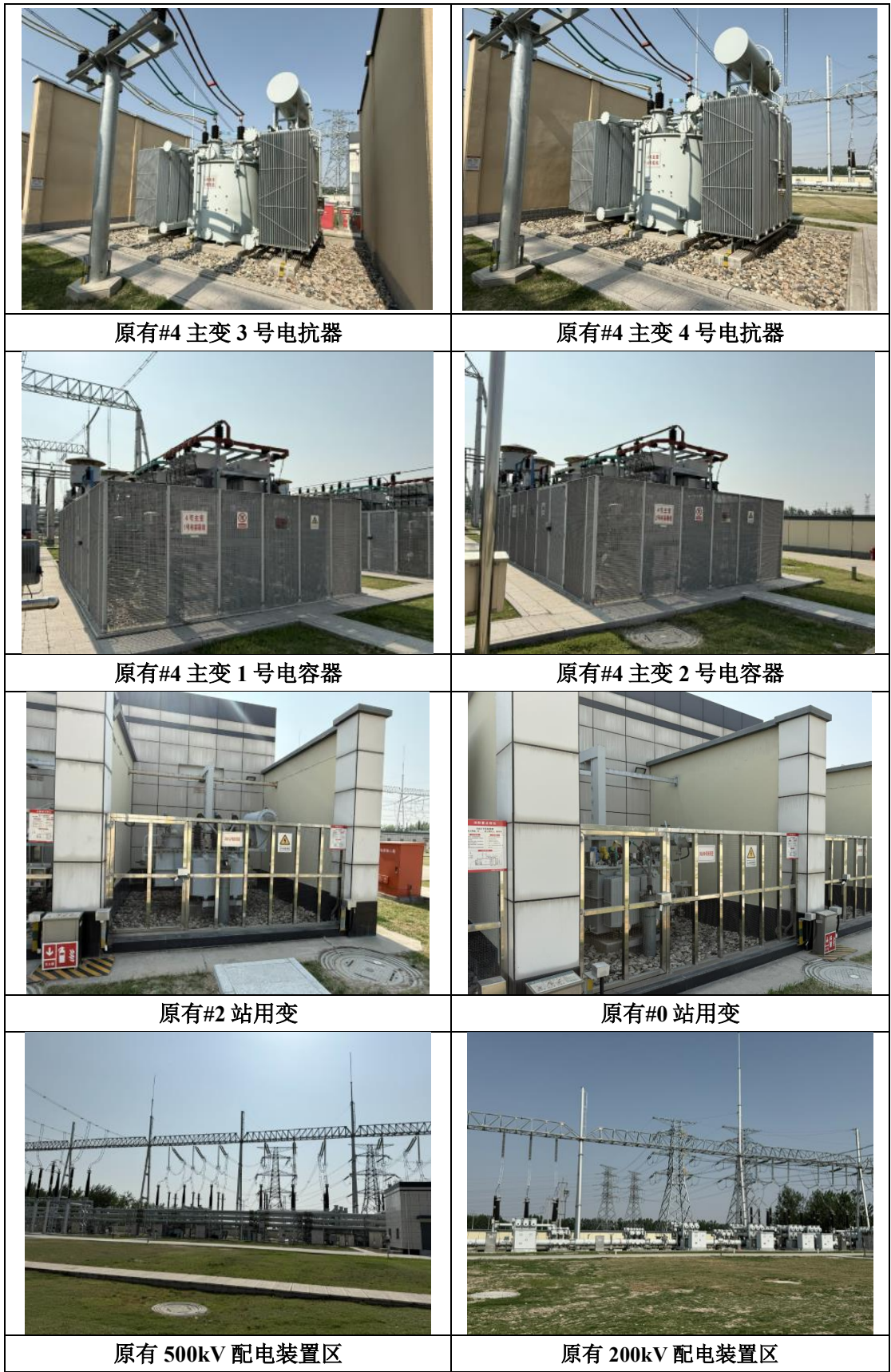
图 3-1-1 沭阳 500kV 变电站原有主体工程照片
