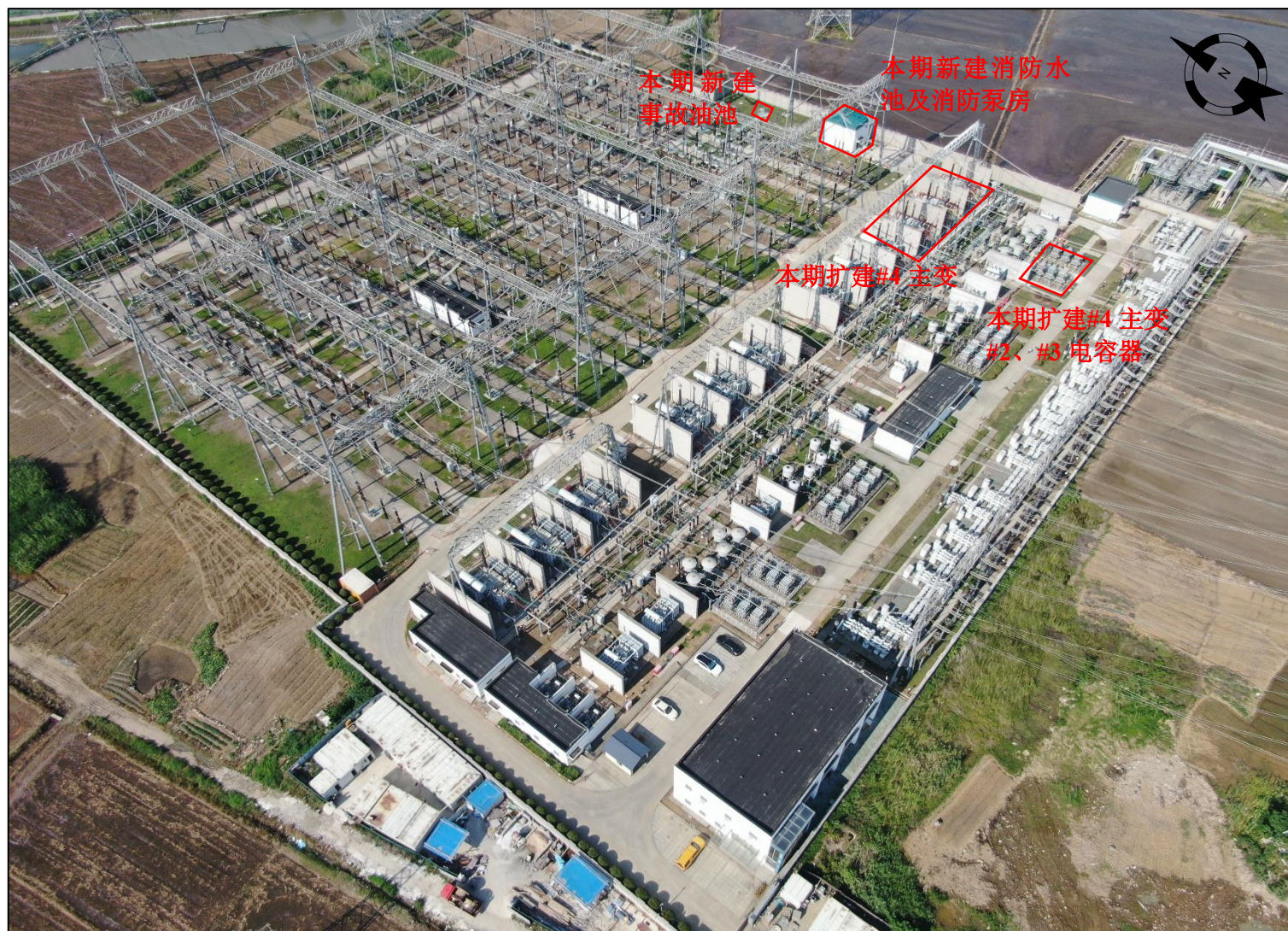
图 3-5 天目湖 500kV 变电站鸟瞰图
