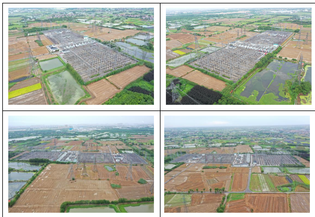
图 6-2 茅山 500kV 变电站站址周围环境现状照片
