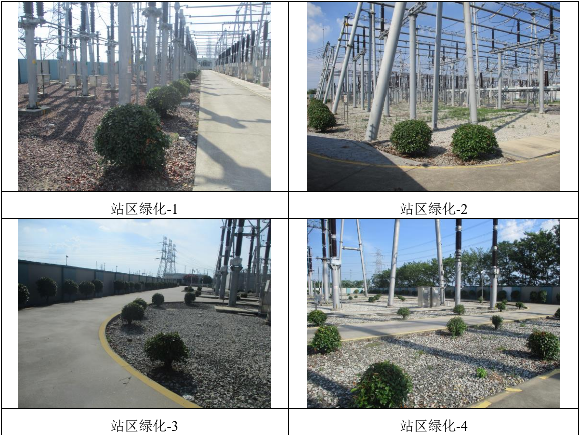
图 5-1 环境保护设施、环境保护措施落实情况照片
