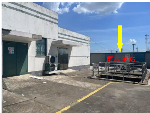
图 9-1 站内雨水泵站
