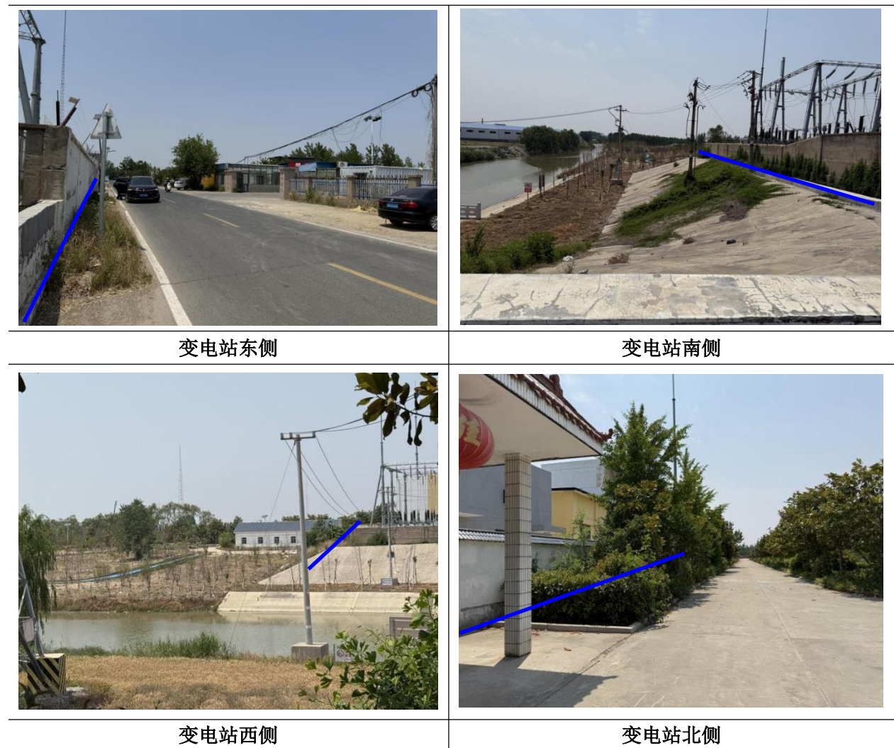
图 4.2 临洪 110kV 变电站站址四周现状照片
