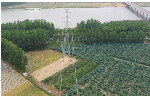
青口河洪水调蓄区东北侧 110kV 梁洪 9AB 线 022#塔
