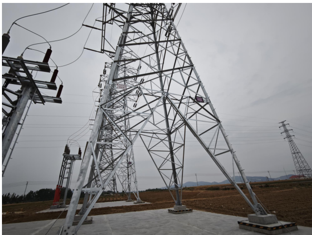
新建电缆终端塔塔基恢复
