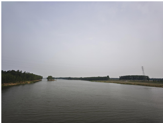
一档跨越青口河洪水调蓄区
