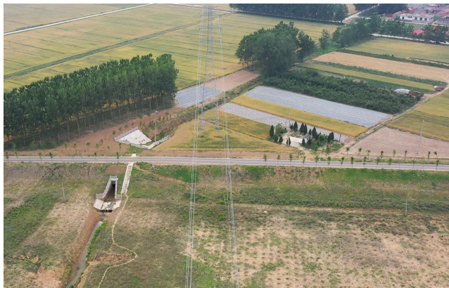
青口河洪水调蓄区西南侧 110kV 梁洪 9AB 线 023#塔
