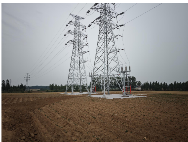
新建电缆终端塔塔基恢复
