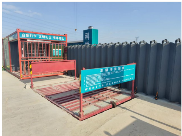
照片 5：防治扬尘（车辆冲洗平台）
