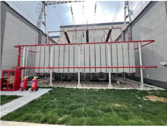
双庙 220kV 变电站#1 主变压器及#1 主变压器事故油坑
