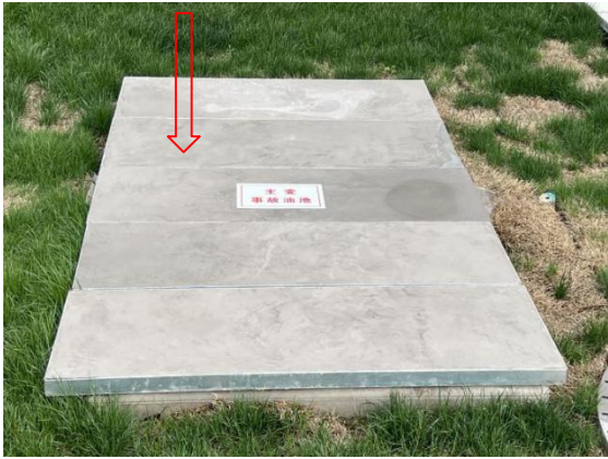
双庙 220kV 变电站事故油池
