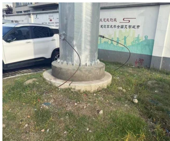
110kV16A9 周林线/110kV16AC 周铝线 塔基恢复情况（#A3）
