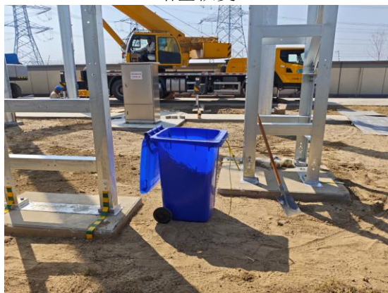
施工现场设置垃圾桶
