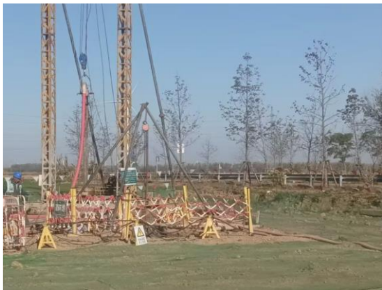
施工期防尘网苫盖
