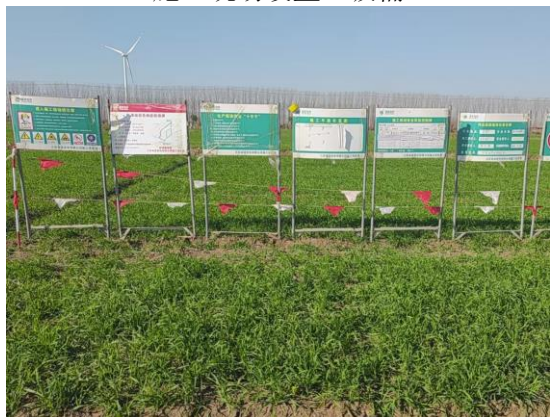
施工现场采取彩条旗限界
