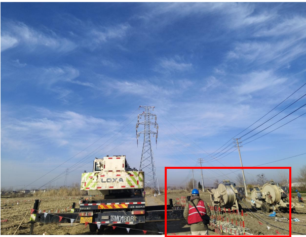
施工围栏以及张力架线
